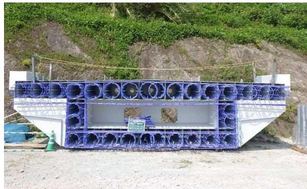
写真 6 鋼殻セル配筋後の接合桁
