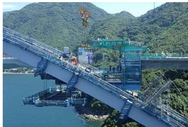
写真 7 接合桁架設状況
