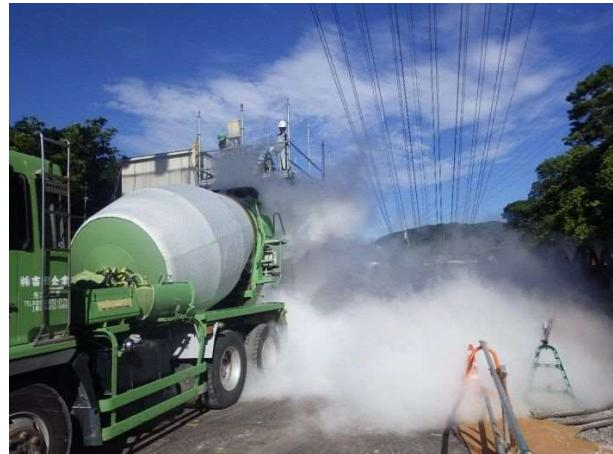
写真10 液体窒素の噴射状況
