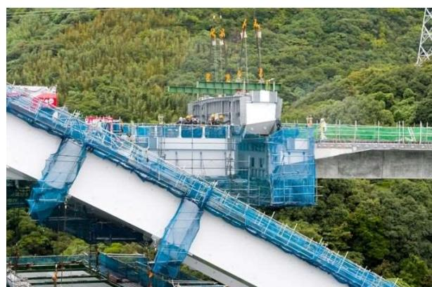
写真11 閉合桁の架設状況
