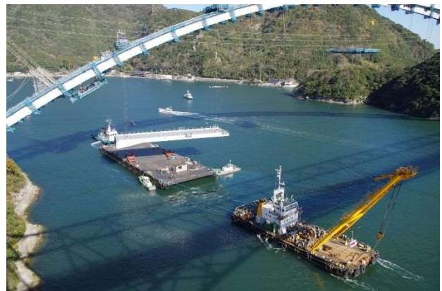
写真5 鋼補剛桁の直下吊架設状況
