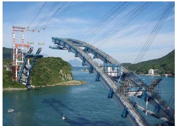
写真3 鋼アーチリブの架設状況
