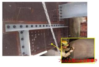
写真-5.37 腐食部切断時剛性保持材の設置
