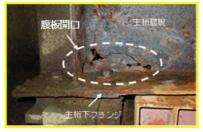
写真-5.31 桁端主桁部の腐食状況
