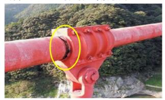
写真-5.2 ラッピングワイヤ塗膜劣化状況
