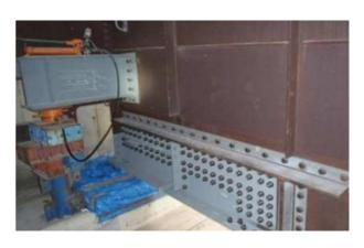
写真-5.39 新規部材取付け状況
