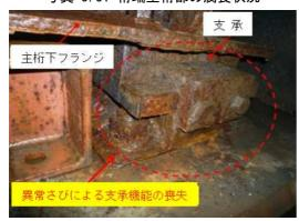
写真-5.32 支承部の腐食状況
