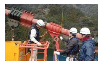
写真-5.12 ハンガーロープの取替状況
