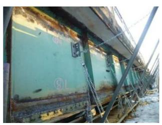
写真-5.25 水平補強材撤去完了
