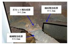
写真-5.33 横構の腐食状況
