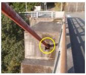
写真-5.5 各部材同士の境界部 (腐食しやすい部位) (3) 対策
