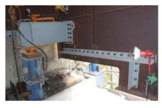
写真-5.38 支承撤去, 主桁腐食部切断状況
