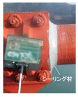
写真-5.6 ケーブルバンド部の防水処置
