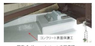
写真-5.40 コンクリート表面保護工
