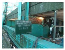
写真-5.18 垂直補剛材切断
