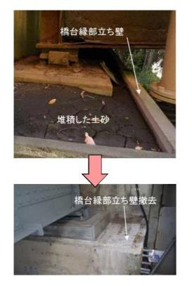
写真-5.41 橋台縁部立ち壁の撤去
