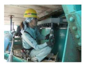
写真-5.19 部材取付, 本締め
