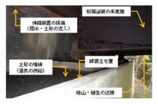
図-5.35 桁端部の構造的腐食要因
