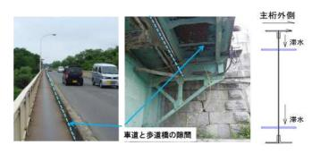
写真-5.22 車道と歩道の隙間からの漏水
