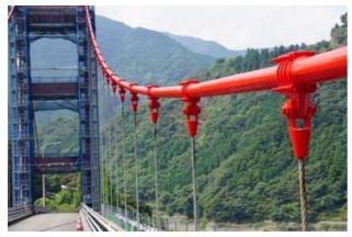
写真 - 5.13 ケーブル廻りの塗替え状況
