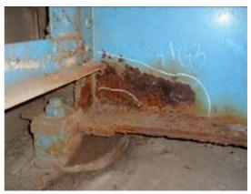
写真-2.1 桁端部の局部的な腐食事例
