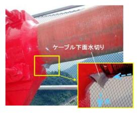
写真-5.7 ケーブル下面水切りの設置
