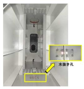
写真 - 5.14 主塔横梁の塗替えおよび水抜き孔の設置 (4) 補修のポイント
