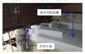
写真-5.42 橋台面排水勾配および水切り板の設置 (4) 補修のポイント
