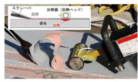
写真-4.2 電磁誘導 (IH) 工法による塗膜剥離状況 ③ブラスト面形成動力工具 (ブリストルブラスター)
