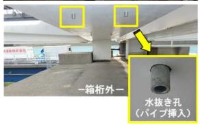
写真-3.2 下フランジへの水抜き孔設置例
