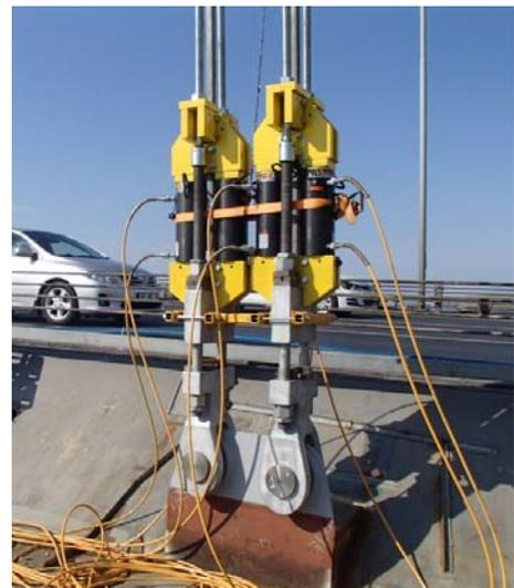
写真-1 ハンガー張力調整機構
