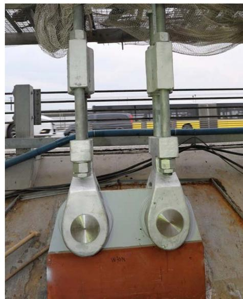
写真-2 張力調整後のハンガー基部
