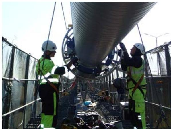
写真-11 エラストメリックラッピング作業
