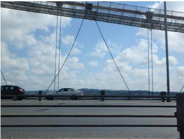
写真-4 新設ハンガー張力導入状況
