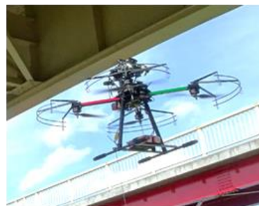
▲橋梁の損傷写真を撮影する技術
