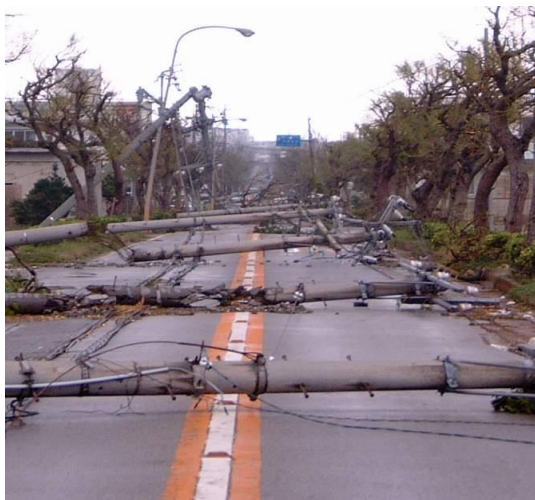
＜電柱の倒壊による道路閉塞＞
