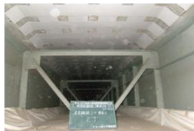
炭素繊維シートの貼り付け
