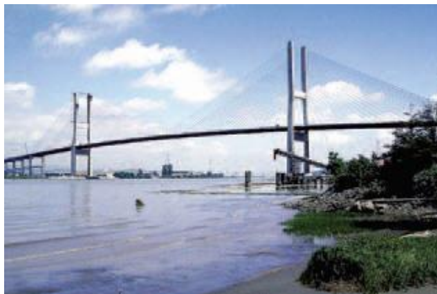
アレックス フレーザー橋
