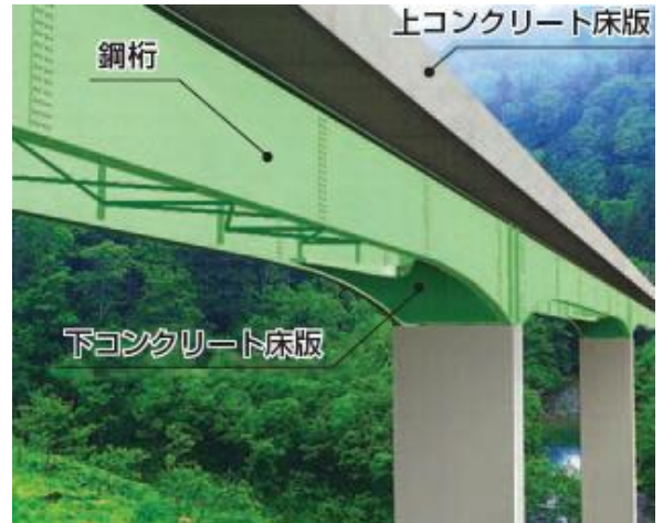
二重合成複合ラーメン橋の構造
