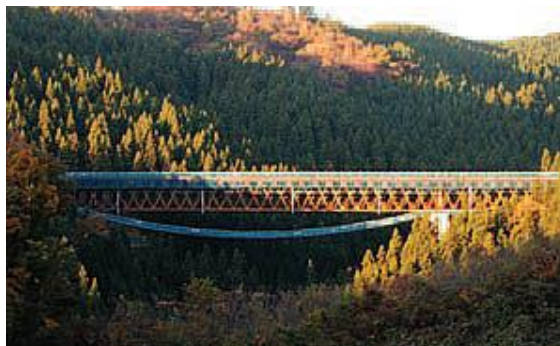
閉合時の渡瀬橋
