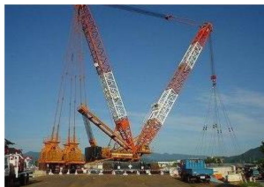
クローラクレーン
