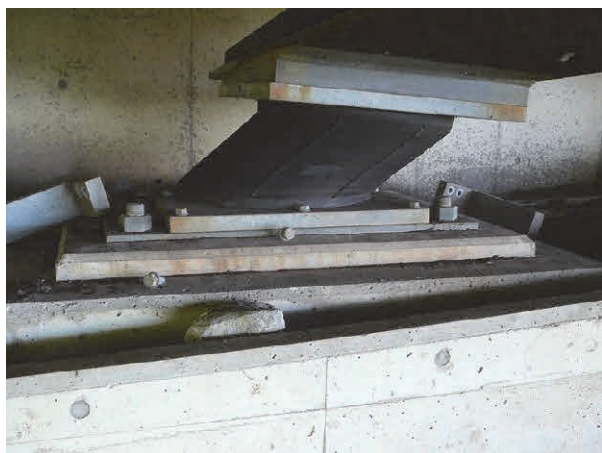
写真-7.2 サイドブロックと変位制限コンクリートの破損（扇の坂橋）
