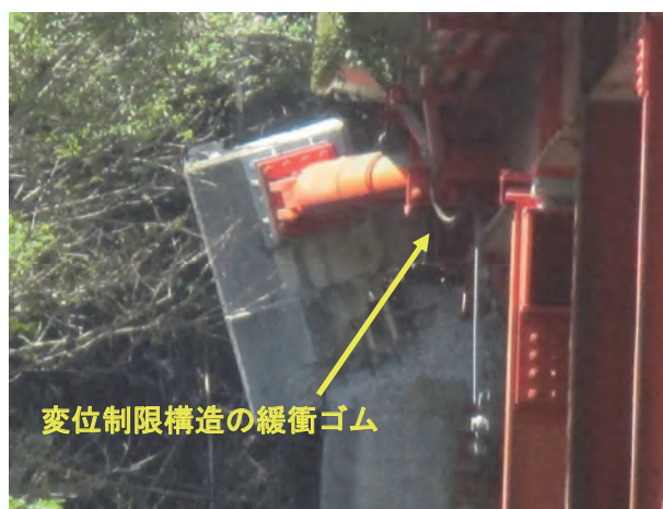
写真-7.3 A2 橋台の制振ダンパー定着部の破損（南阿蘇橋）
