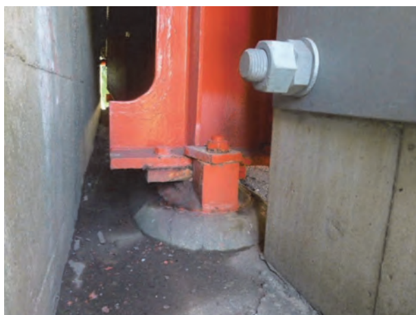
写真-7.4 A1 橋台支承の橋軸方向への移動痕（南阿蘇橋）
