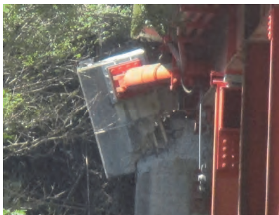
写真-8.7 A2 橋台の制振ダンパー定着部の破損（南阿蘇橋）
