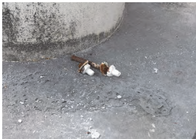
写真-6.60 ボルトの抜け落ち、床版の損傷
