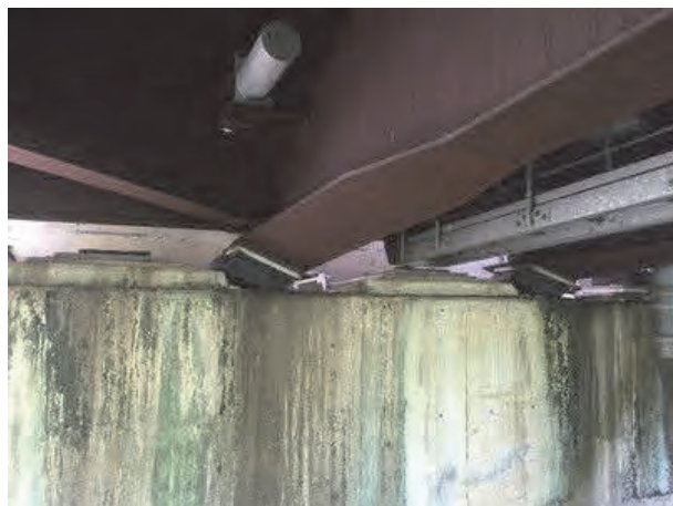
写真-7.13 A2 橋台ゴム支承の破断と落橋防止ケーブル（大切畑大橋）
