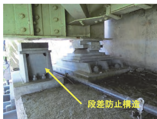
写真-7.20 段差防止構造の設置（小島橋）
