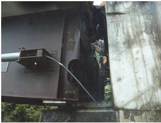
写真-8.3 A1 橋台落橋防止ケーブル切断と横桁ケーブル貫通孔の切断痕（大切畑大橋）
