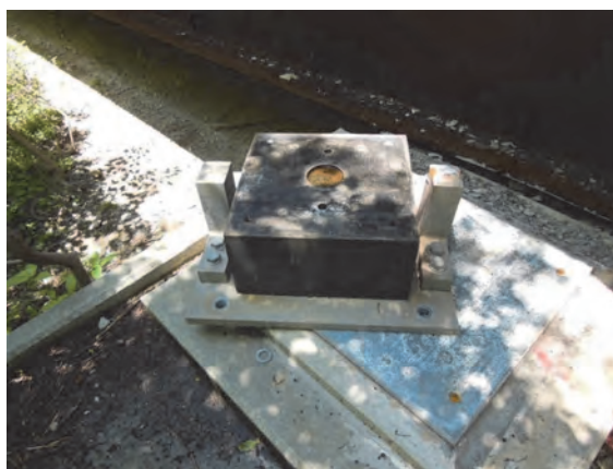
写真-7.1 A2 橋台主桁脱落とゴム支承セットボルトの破断（俵山大橋）
