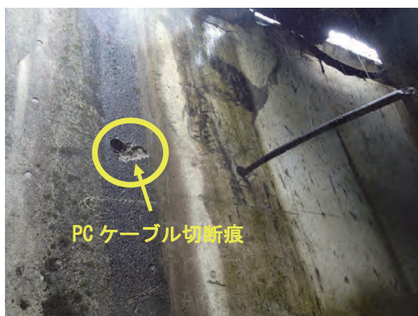
写真-7.14 A1 橋台パラペットと横桁ケーブル貫通孔の落橋防止ケーブル切断痕（大切畑大橋） （大切畑大橋はパラペット貫通孔にトランペットシースを使用していない）
