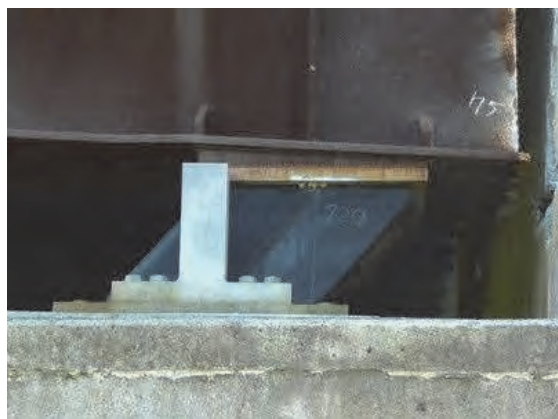
写真-7.15 A1 橋台ゴム支承の変形と主桁腹板等の座屈（俵山大橋）
