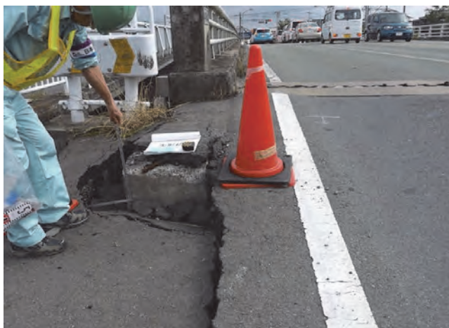
写真-6.42 左岸側 橋台背面の沈下
