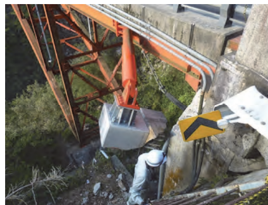
写真-8.7 A2 橋台の制振ダンパー定着部の破損（南阿蘇橋）
