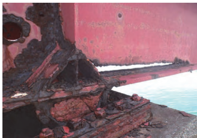
写真-6.51 陸上側支点部の腐食損傷
