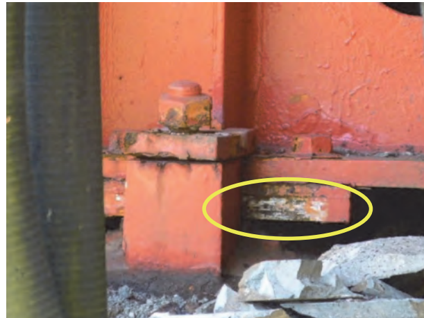
写真-7.4 A1 橋台支承の橋軸方向への移動痕（南阿蘇橋）
