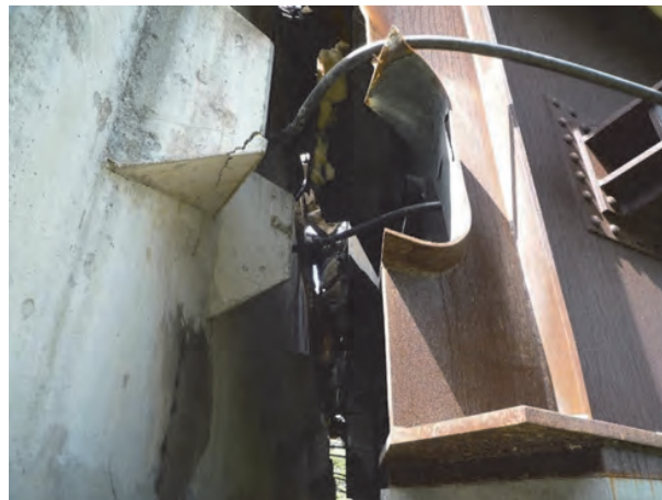
写真-7.13 A2 橋台ゴム支承の破断と落橋防止ケーブル（大切畑大橋）
