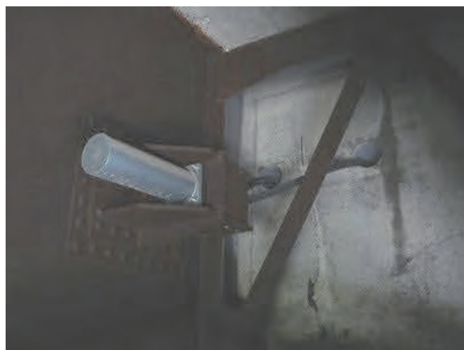
写真-7.6 俵山大橋の状況
