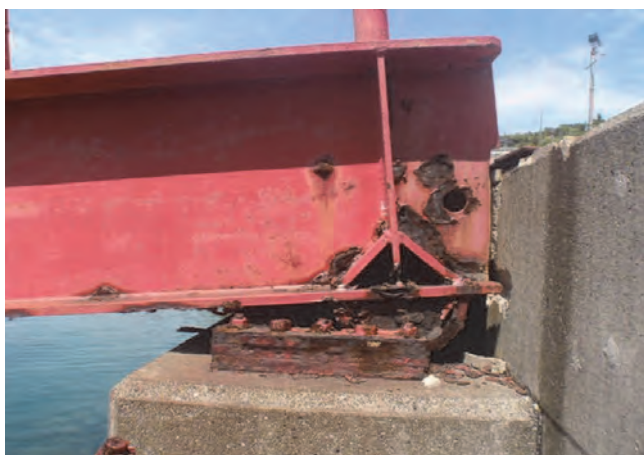
写真-6.51 陸上側支点部の腐食損傷
