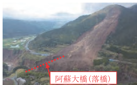
写真-8.11 阿蘇大橋付近の斜面崩壊 2)
