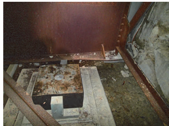
写真-8.4 A2 橋台ゴム支承セットボルトの破断（俵山大橋）
