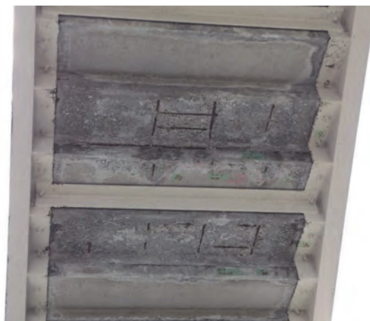
写真-6.60 ボルトの抜け落ち、床版の損傷
