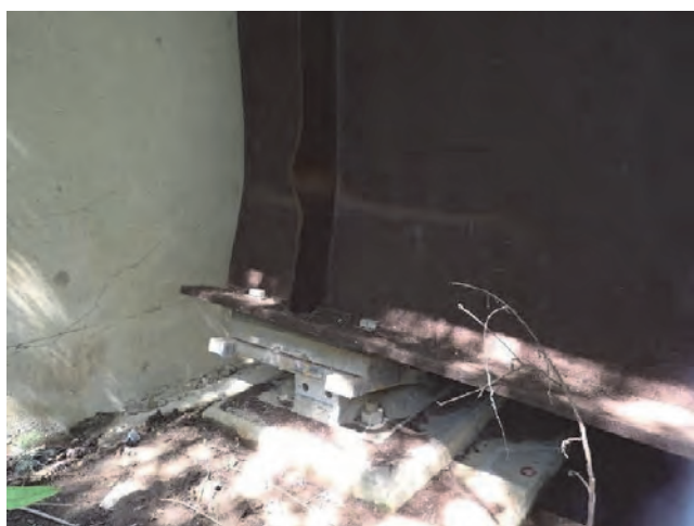
写真-6. 25 A2 橋台 主桁の変形、支承の損傷
