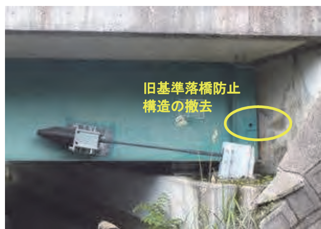
写真-7.21 旧基準の落橋防止撤去事例（小ヶ瀬橋）
