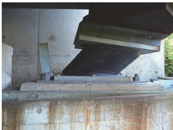
写真-7.18 支承の変形と垂直補剛材の座屈（扇の坂橋）
