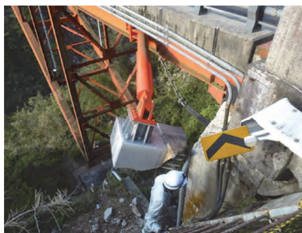
写真-7.3 A2 橋台の制振ダンパー定着部の破損（南阿蘇橋）
