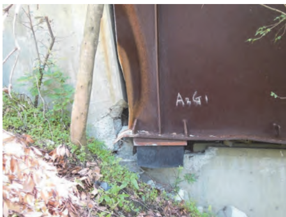
写真-7.1 A2 橋台主桁脱落とゴム支承セットボルトの破断（俵山大橋）
