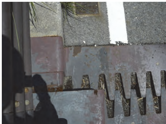
写真-8.6 A2 橋台伸縮装置とゴム支承の残留変形（扇の坂橋）
