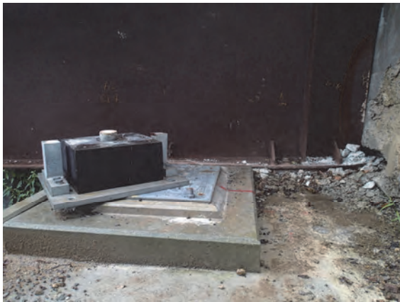
写真-8.4 A2 橋台ゴム支承セットボルトの破断（俵山大橋）
