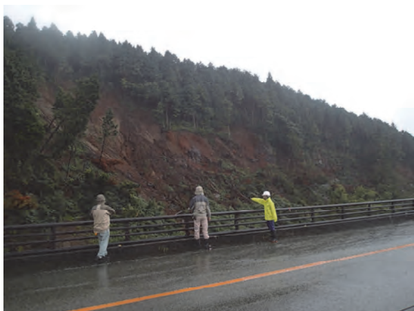
写真-10.2 大切畑大橋付近の斜面崩落と民家の被害状況
