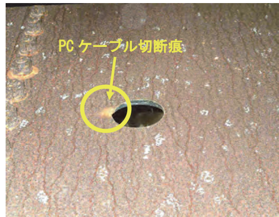
写真-8.3 A1 橋台落橋防止ケーブル切断と横桁ケーブル貫通孔の切断痕（大切畑大橋）
