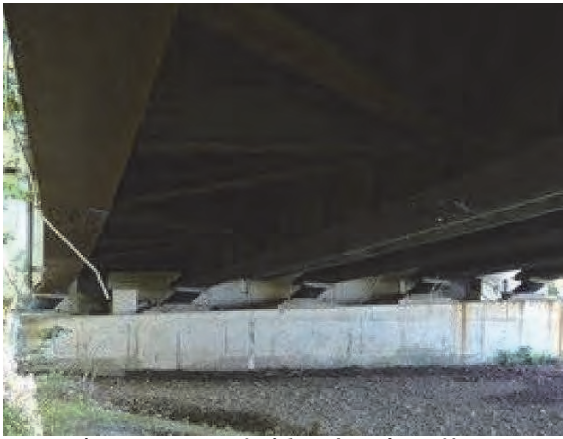
写真-5.7 扇の坂橋 支承部の状況
