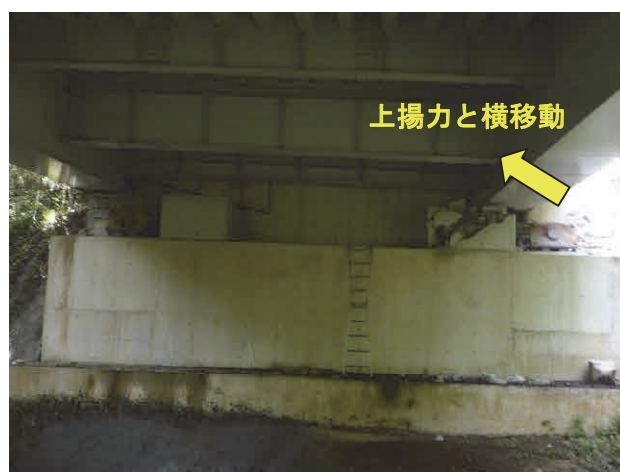
写真-7.12 支承の損傷（主桁脱落）と新基準の変位制限構造の破損（桑鶴大橋、A2 橋台部）
