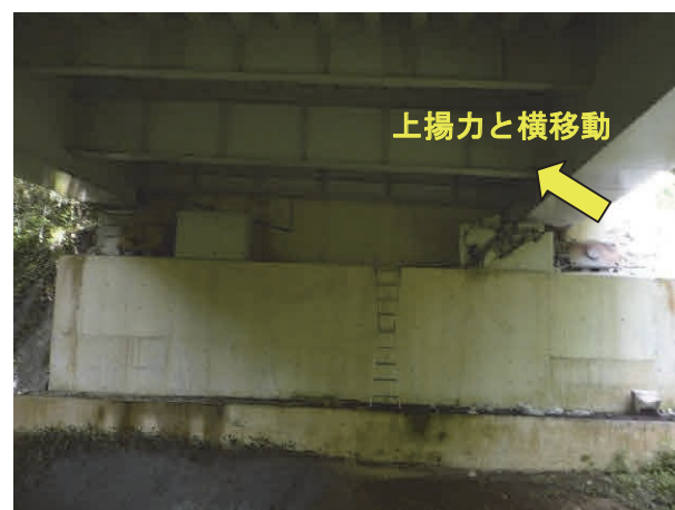
写真-8.5 ケーブルのたるみと A2 橋台（桑鶴大橋）
