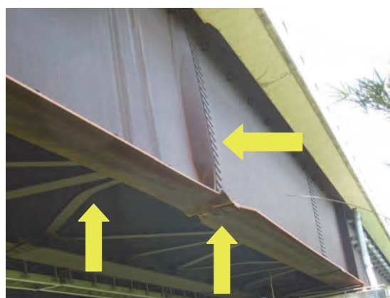
写真-7.15 A1 橋台ゴム支承の変形と主桁腹板等の座屈（俵山大橋）
