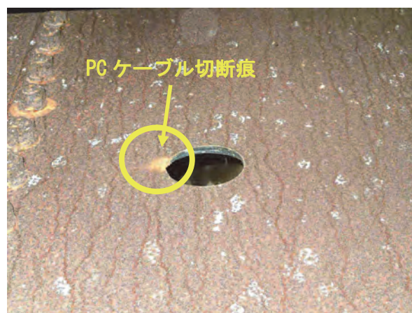
写真-7.14 A1 橋台パラペットと横桁ケーブル貫通孔の落橋防止ケーブル切断痕（大切畑大橋） （大切畑大橋はパラペット貫通孔にトランペットシースを使用していない）
