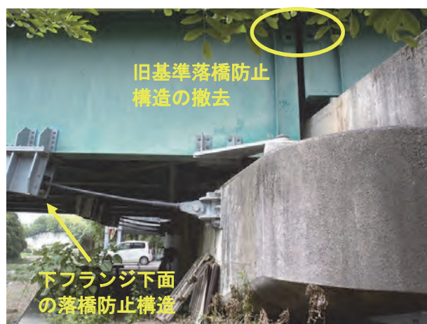
写真-7.21 旧基準の落橋防止撤去事例（小ヶ瀬橋）
