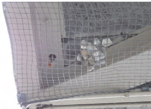
写真-6.60 ボルトの抜け落ち、床版の損傷
