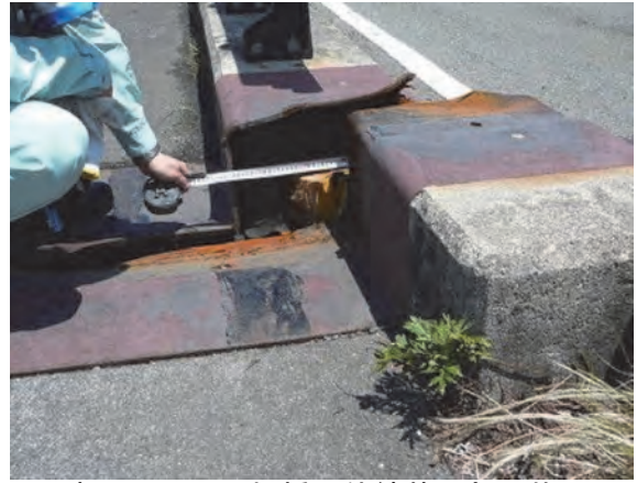
写真-5.8 扇の坂橋 伸縮装置部の状況
