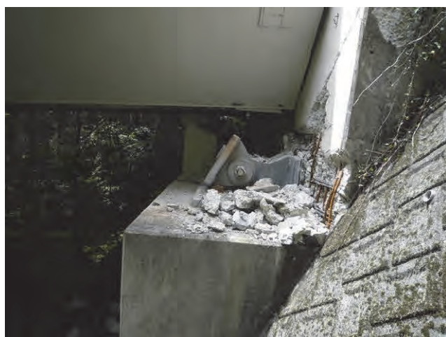
写真-7.12 支承の損傷（主桁脱落）と新基準の変位制限構造の破損（桑鶴大橋、A2 橋台部）
