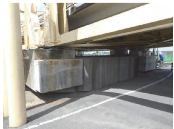
写真-6.20 P3 橋脚（終点側）約 2.25m 沈下
