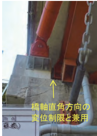
写真-5.10 南阿蘇橋の変位制限構造と横移動痕 7)
