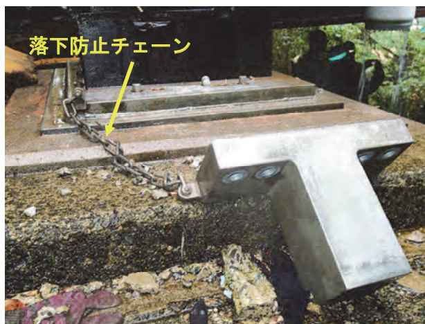
写真-7.17 落下防止チェーン（大切畑大橋）
