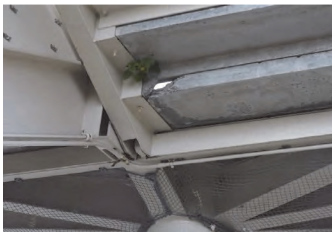
写真-6.61 床版の損傷
