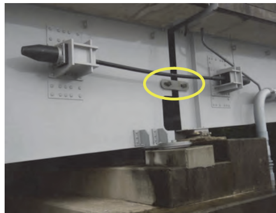
写真-7.8 新旧基準の落橋防止構造の混在
