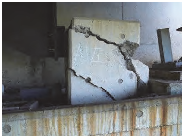
写真-7.2 サイドブロックと変位制限コンクリートの破損（扇の坂橋）
