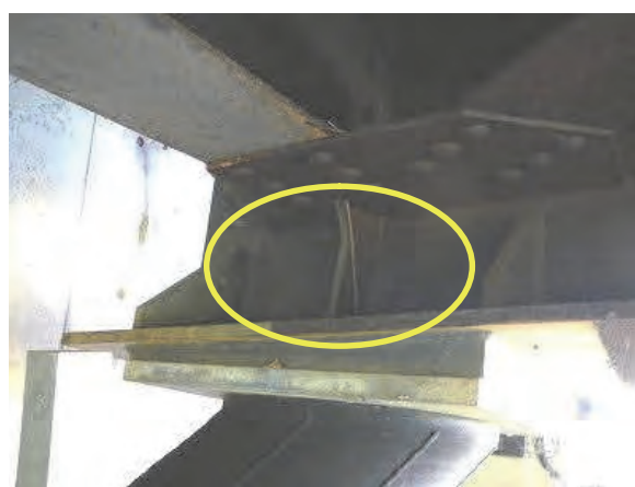
写真-7.18 支承の変形と垂直補剛材の座屈（扇の坂橋）
