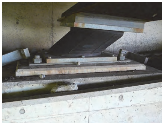
写真-8.6 A2 橋台伸縮装置とゴム支承の残留変形（扇の坂橋）
