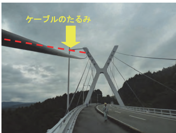
写真-8.5 ケーブルのたるみと A2 橋台（桑鶴大橋）
