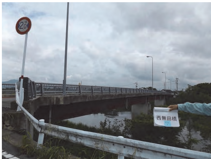
写真-6.45 全景（下流側）
