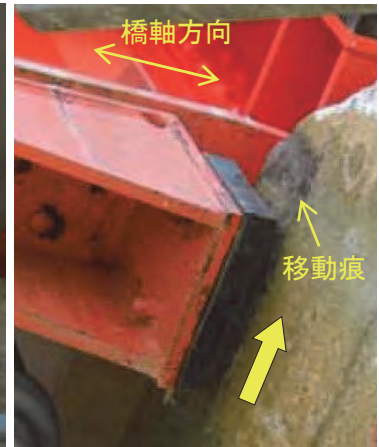
写真-5.10 南阿蘇橋の変位制限構造と横移動痕 7)
