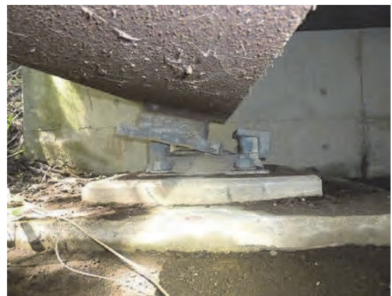
写真-5.14 平成長野大橋 支承部の状況
