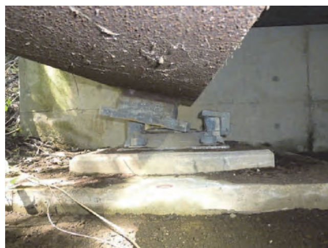
写真-6. 25 A2 橋台 主桁の変形、支承の損傷
