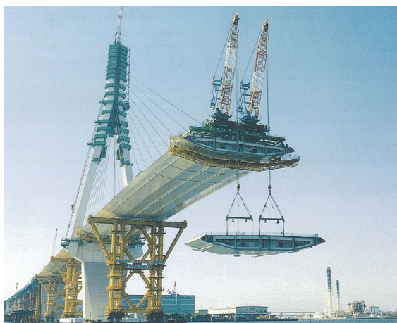
斜張橋主桁の架設
