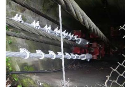
追加ケーブルの定着部への引込みおよび設置作業状況
