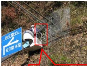
落石防止網の点検孔の設置
