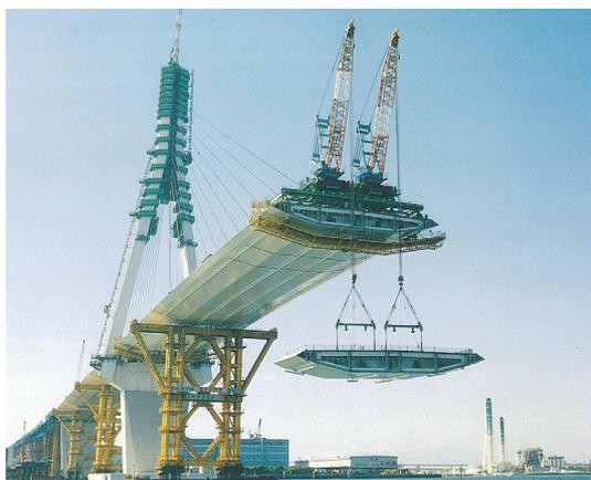
斜張橋主桁の架設
