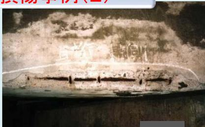
塩害によりかぶりコンクリートが剥離
