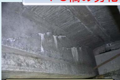
PCグラウトの施工不良により生じたひび割れ
