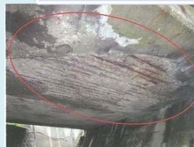
塩害によりかぶりコンクリートが剥離
