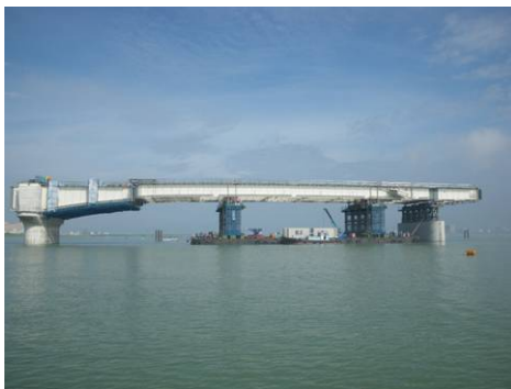
写真－4 台船架設状況
