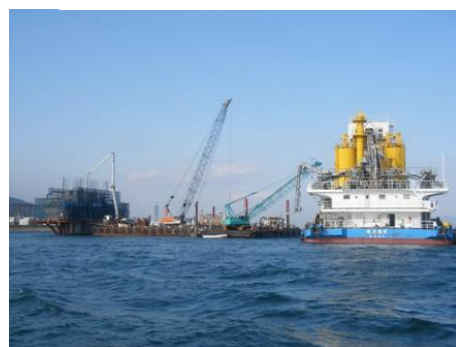
写真－2 コンクリートプラント船による打設
