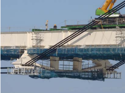
写真－14 本ケーブル架設完了
