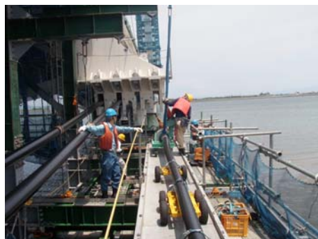
写真－9 水平ケーブル展開・架設
