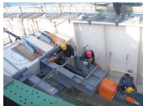
写真-8 バックステイケーブル定着
