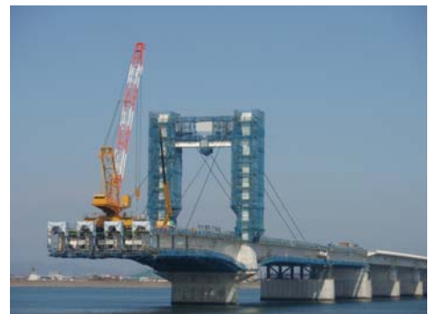
写真－6 中央径間張出し架設
