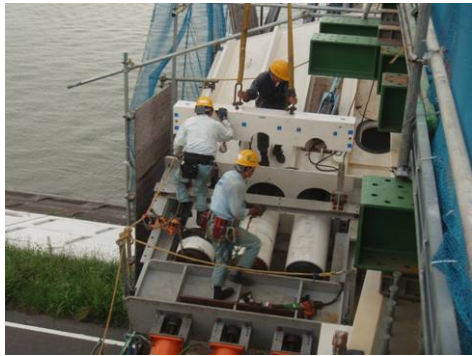
写真－13 側径間斜ケーブル架設
