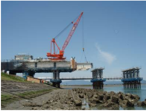
写真－3 P1～P2 側径間架設
