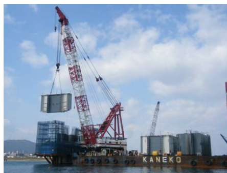
写真－1 主塔基部架設
