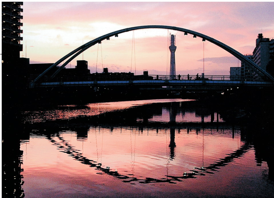
■撮影者:羽田 修 ■撮影時期:平成22年9月 ■撮影場所:東京都江東区 ■撮影データ:キャノン EOS40D 24~105mm 絞り優先 1/30秒
