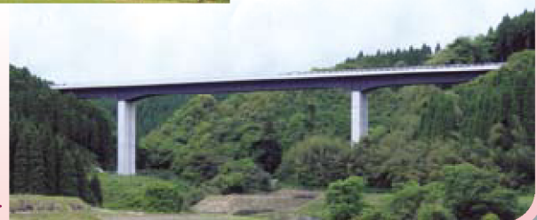
今別府川橋／3径間連続複合ラーメン橋 ▲▶
