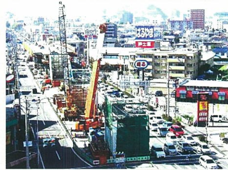
写真4 上部工(写真奥)と基礎の同時施工
