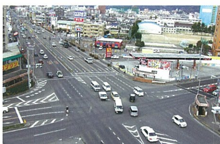
写真1 施工前の小坂交差点
