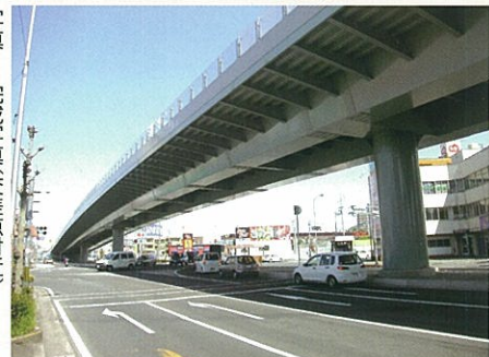
写真6 完成写真(交差点付近)
