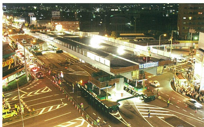
写真2 交差点の夜間一括架設の状況
