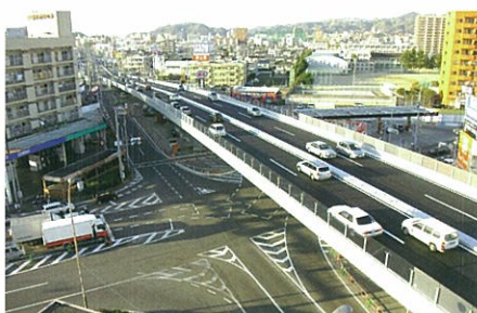
写真3 施工後の小坂交差点
