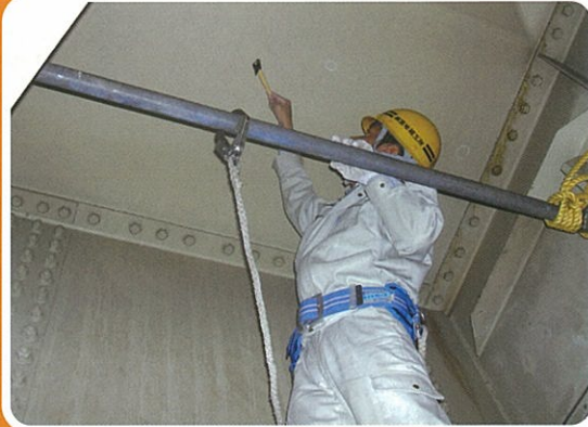
底鋼板をテストハンマで打音(たたき)試験を行い、空隙箇所、鋼板とコンクリートの付着切れ・はく離箇所等を定性的に把握します。
