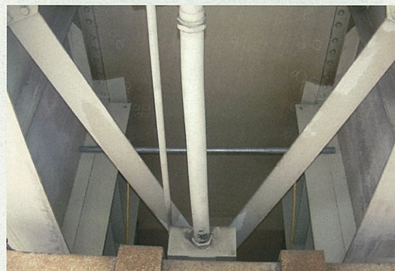
床版支間中央部下面の状況
