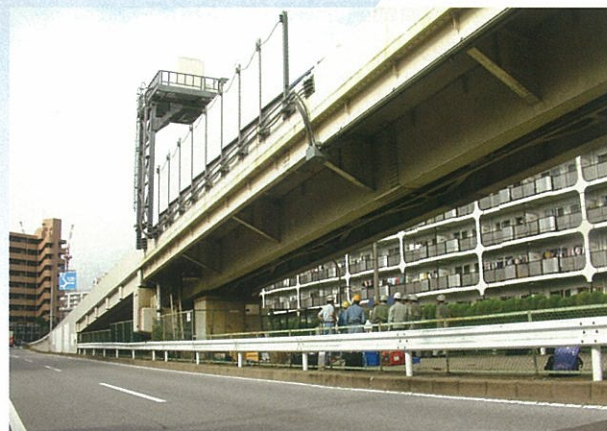
首都高速道路・9号深川線枝川ランプ
