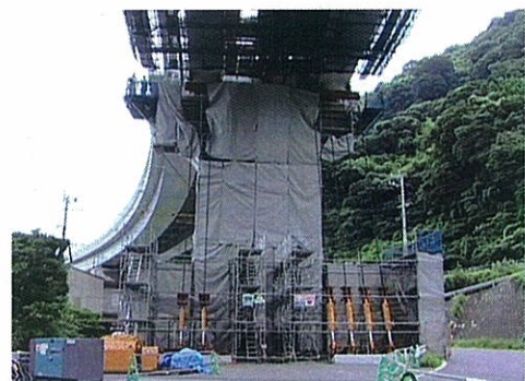
写真4 端支点負反力対策の状況
