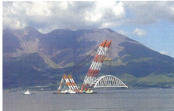
写真2 中央径間大ブロック吊曳航の状況
