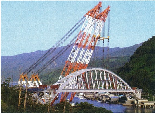
写真1 中央径間大ブロック架設状況
