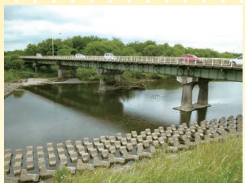
九年橋全景(大規模修繕前)
