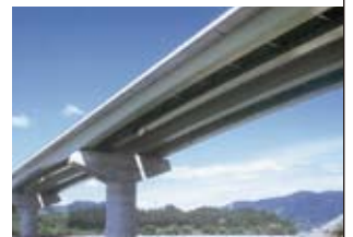
写真-2 細幅箱桁橋
