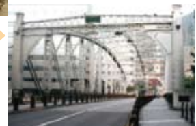
写真一7 南高橋 旧両国橋の材料を 利用し昭和7年竣工
