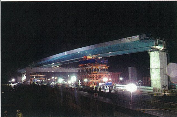
写真1 夜間一括架設の状況
