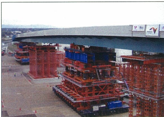
写真3 仮設備の状況
