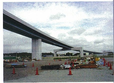
写真4 Bランプ完成状況
