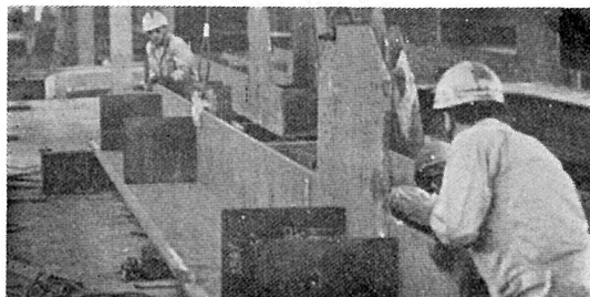
写真 2 主構弦材の組立
