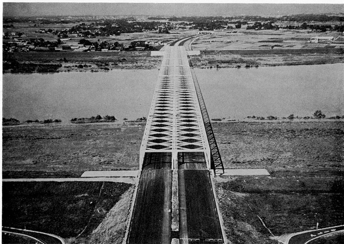
利根川橋（東北高速道路）
