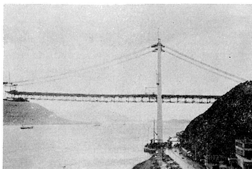
下関側主塔下より
