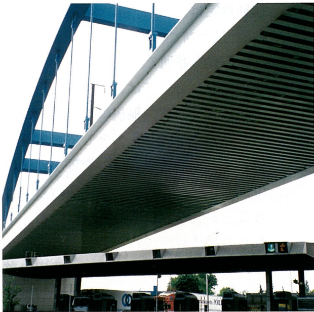
写真4 埋め込み式床桁の下面
