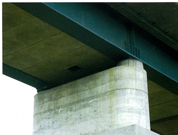
写真2 プレキャストコンクリート版の取り付け状況
