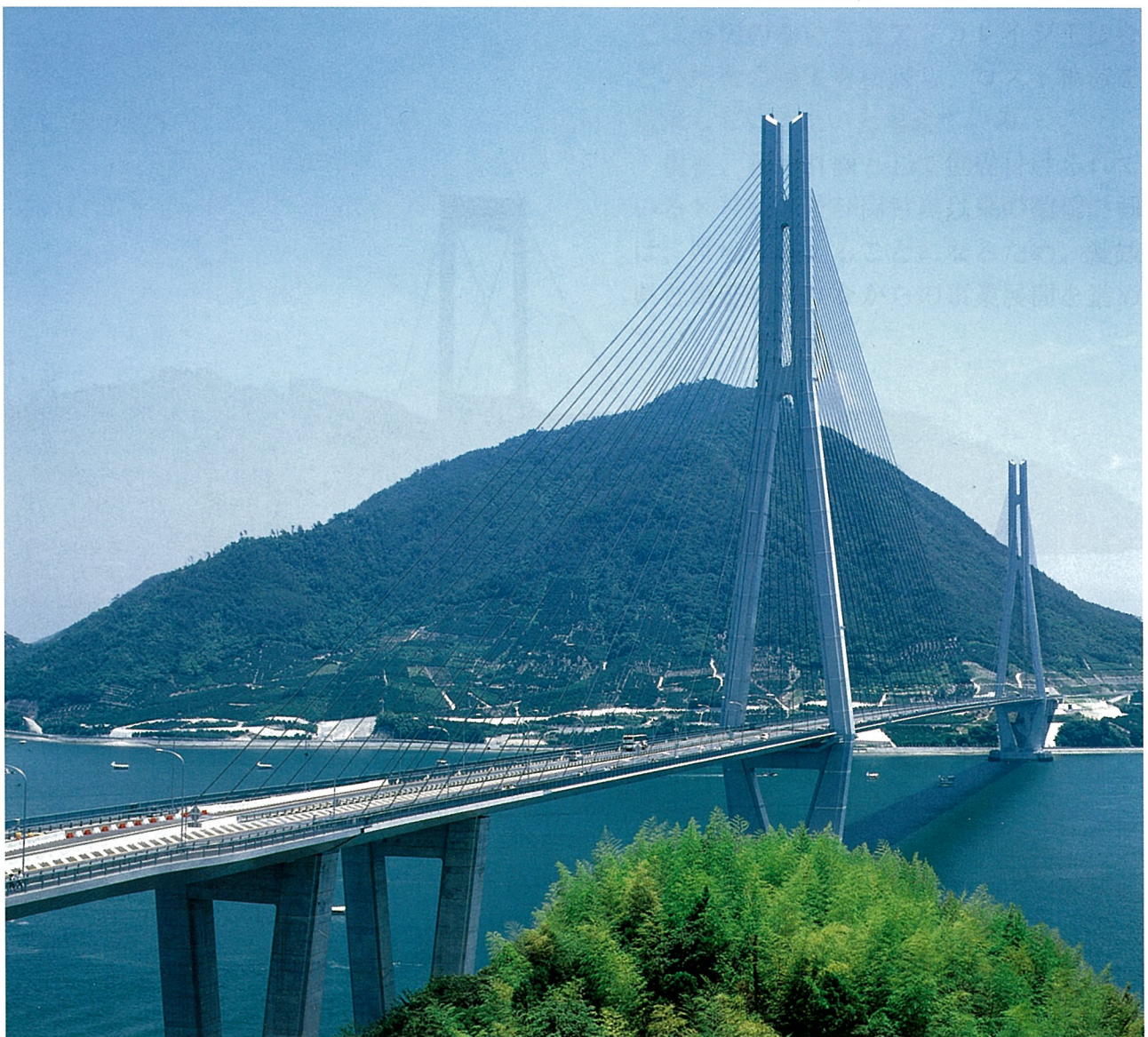
多々羅大橋
