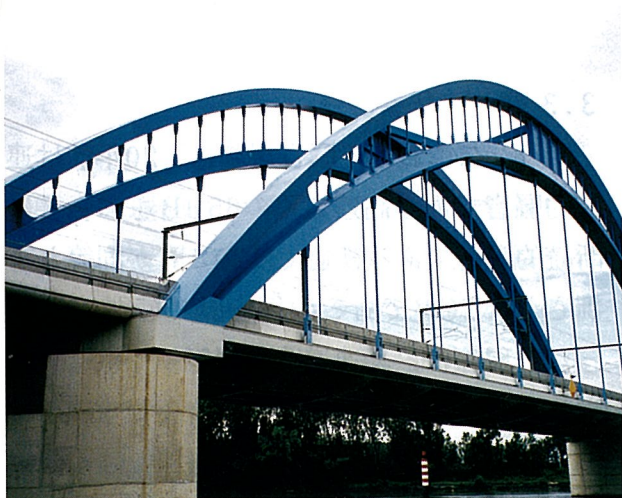
写真5 モルナス高架橋
