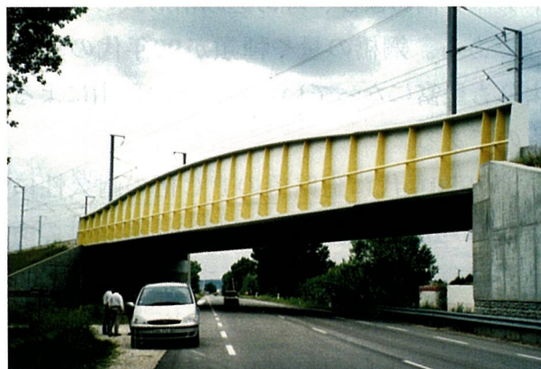
写真3 国道上の下路桁
