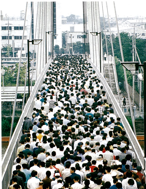
図－５ 歩行者により横揺れする歩道橋 (斜張橋)
