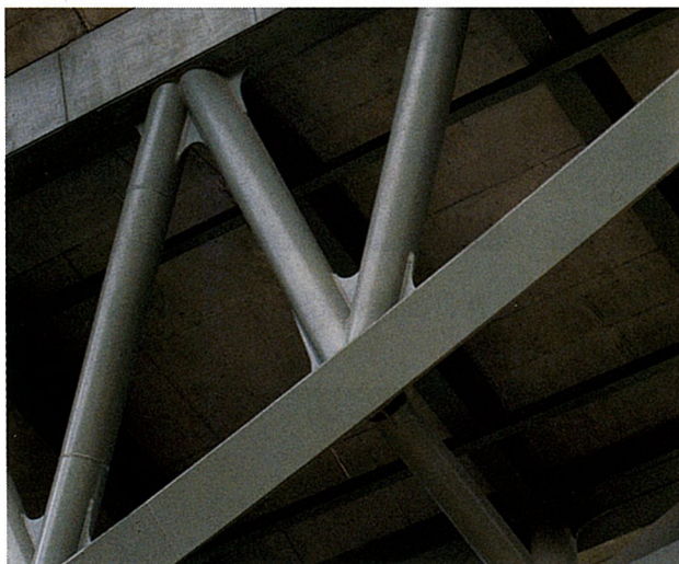
写真10 アルク高架橋 腹材トラス格点部
