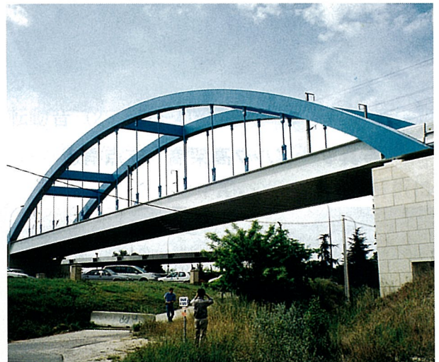
写真7 A7 高速道路料金所の跨道橋
