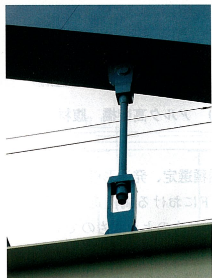
写真8 上記跨道橋の吊材
