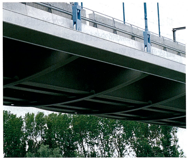
写真6 モルナス高架橋床構造
