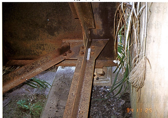
支承部(桁端部)
