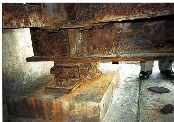
支承部(桁端部)
