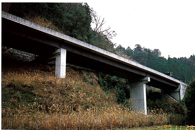
写真－12 地山が接近した桁(中間橋脚付近が地山に接近)
