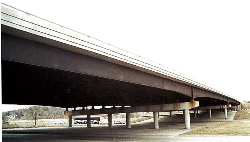
写真－４・３・５ セントポールの掘り割り式交差橋梁 (1973年頃架設 側壁のり面の空間、桁下空間が十分にとられていて、さび状態は非常によい)
