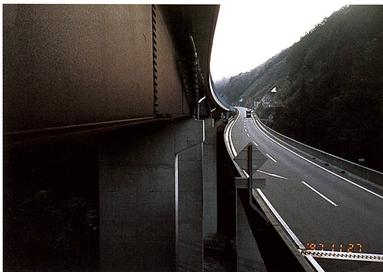
写真－10 上下線橋梁の高低差
