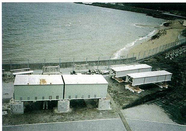
写真-1 沖縄建設材料耐久性施設
