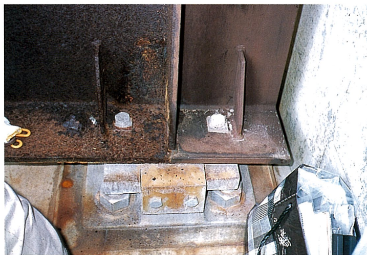
写真－６ 壁高欄隙間からの越流水
