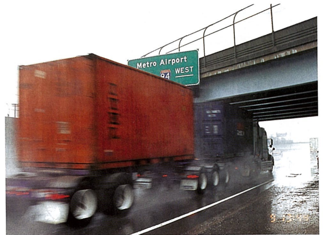
写真－４・３・２ デトロイトの掘り割り式交差橋梁 (1970年頃架設 1996年に全面補修塗装)
