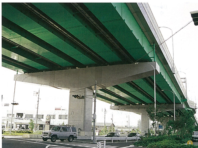
写真-1 景観処理の例(右の箱桁3本が耐候性景観処理桁を、左の箱桁3本は通常の塗装処理で施工)
