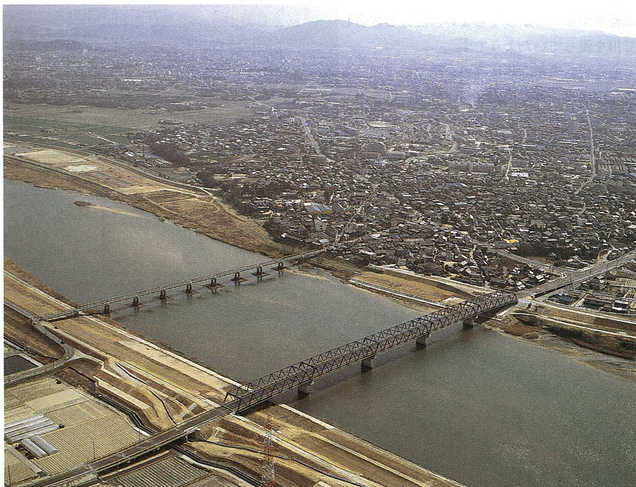
中畑橋（写真の上側の橋は旧橋で現在は撤去されています）
