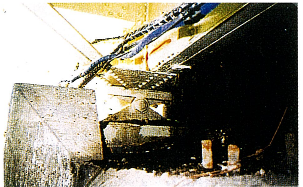
写真-13 支承取替前の状況
