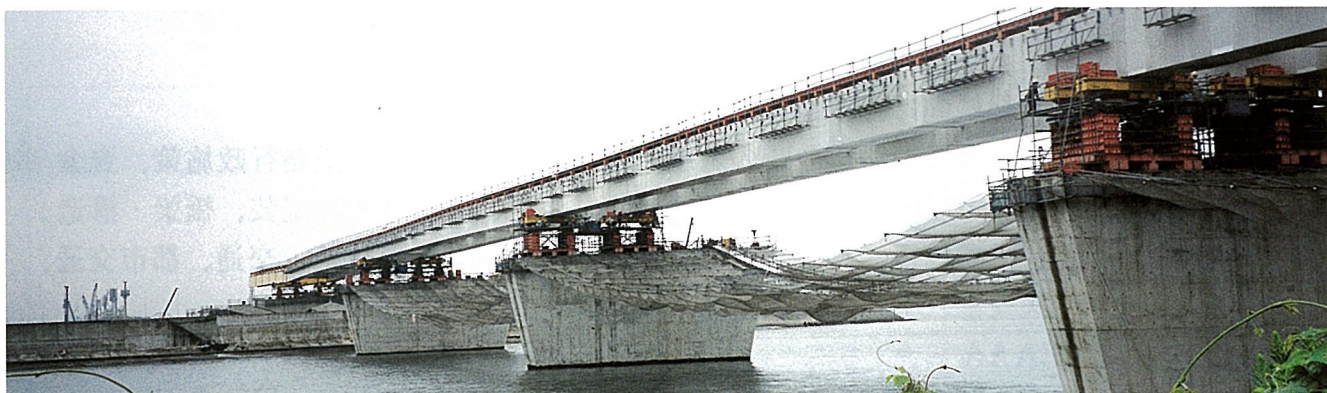
写真－3 送り出し中の橋桁
