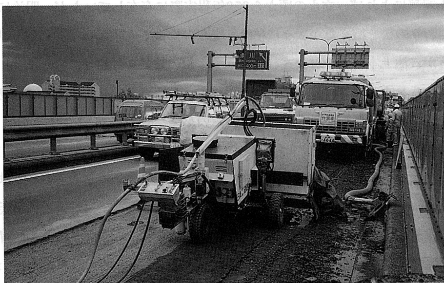
写真－２ ウォータージェットによるコンクリート舗装切削例 4)
