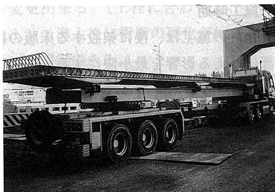
写真－４ 床版運搬状況
