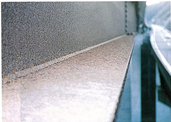
写真-12 上・下線段差構造
