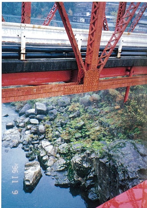
写真－２ a 鬼淵橋の格点部構造。
