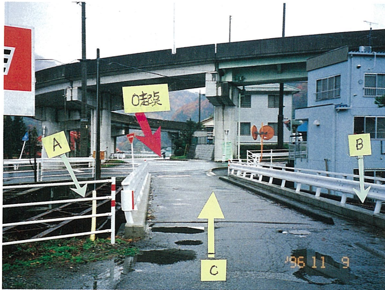
写真－4 森林鉄道の跡 道路橋（C）を挟んで両側に森林鉄道用の鉄桁（A／B）が残されている。道路橋も同じ頃。
