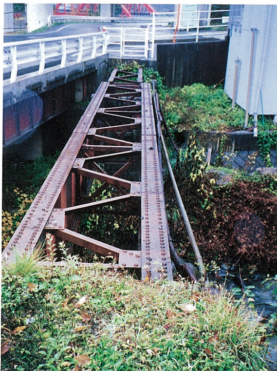
写真－5 鉄桁 B 上松貯木場に入る森林鉄道用の旧鉄桁。橋歴板から1913年（大正2年）製作。
