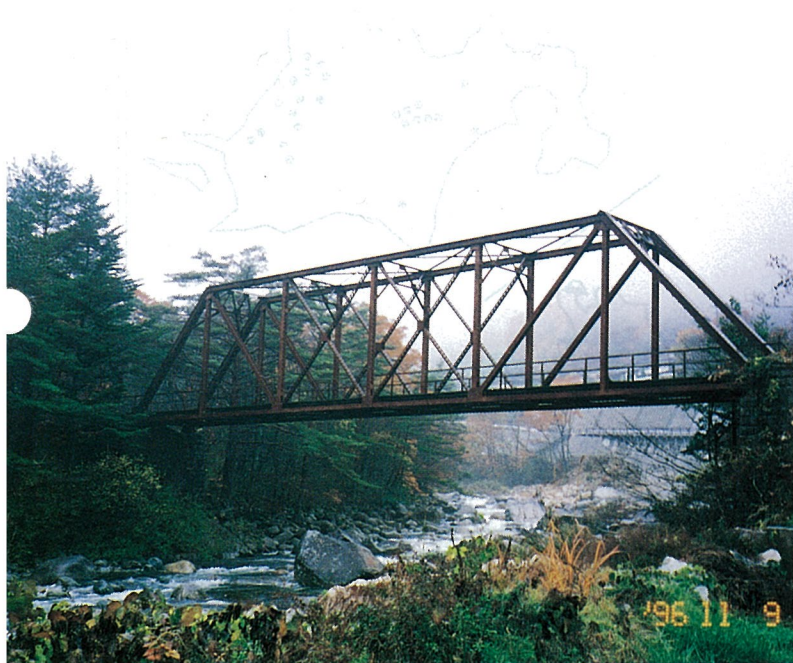
写真－３ 小田野橋 橋には「大阪 横河橋梁製作所 製作」のプレートが弦材に付いているが橋の名称は付いていない。この辺りの地名は小田野。
