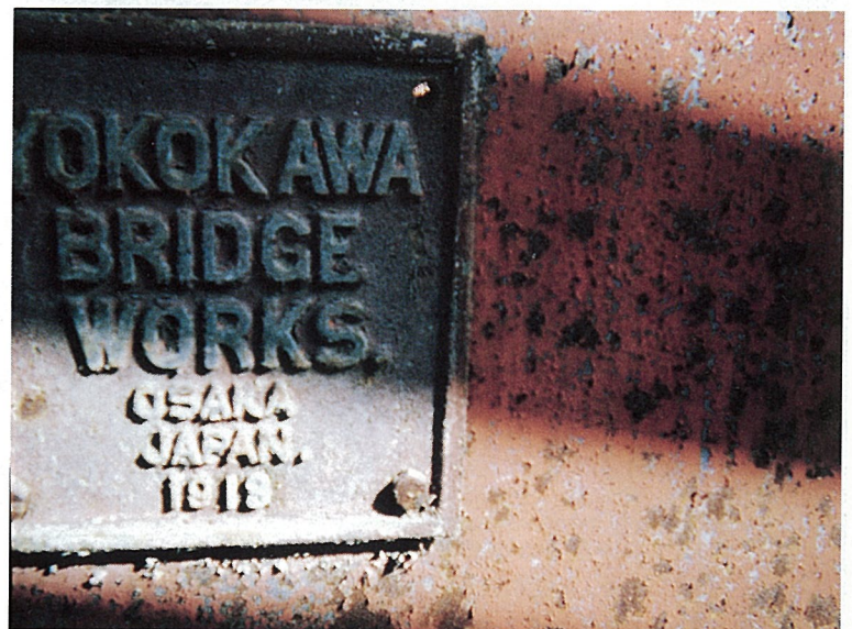
写真－5 a 橋歴板
