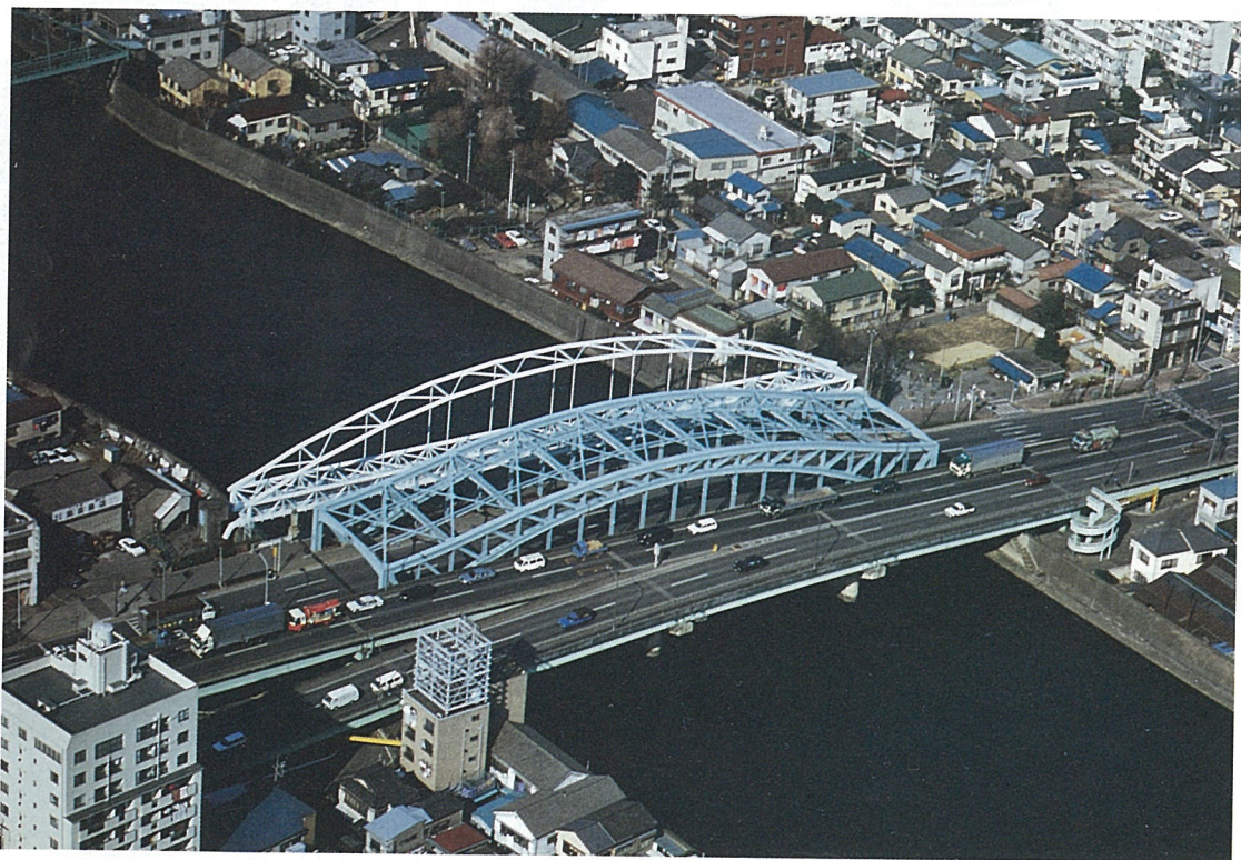
写真－22 千住大橋
