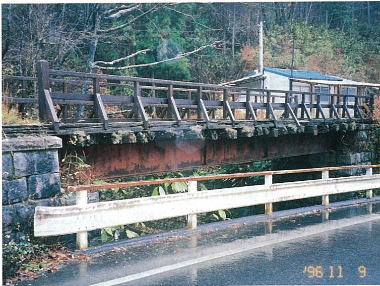
写真－6 小仲間停車場跡に残されている小川森林鉄道用鉄桁。
