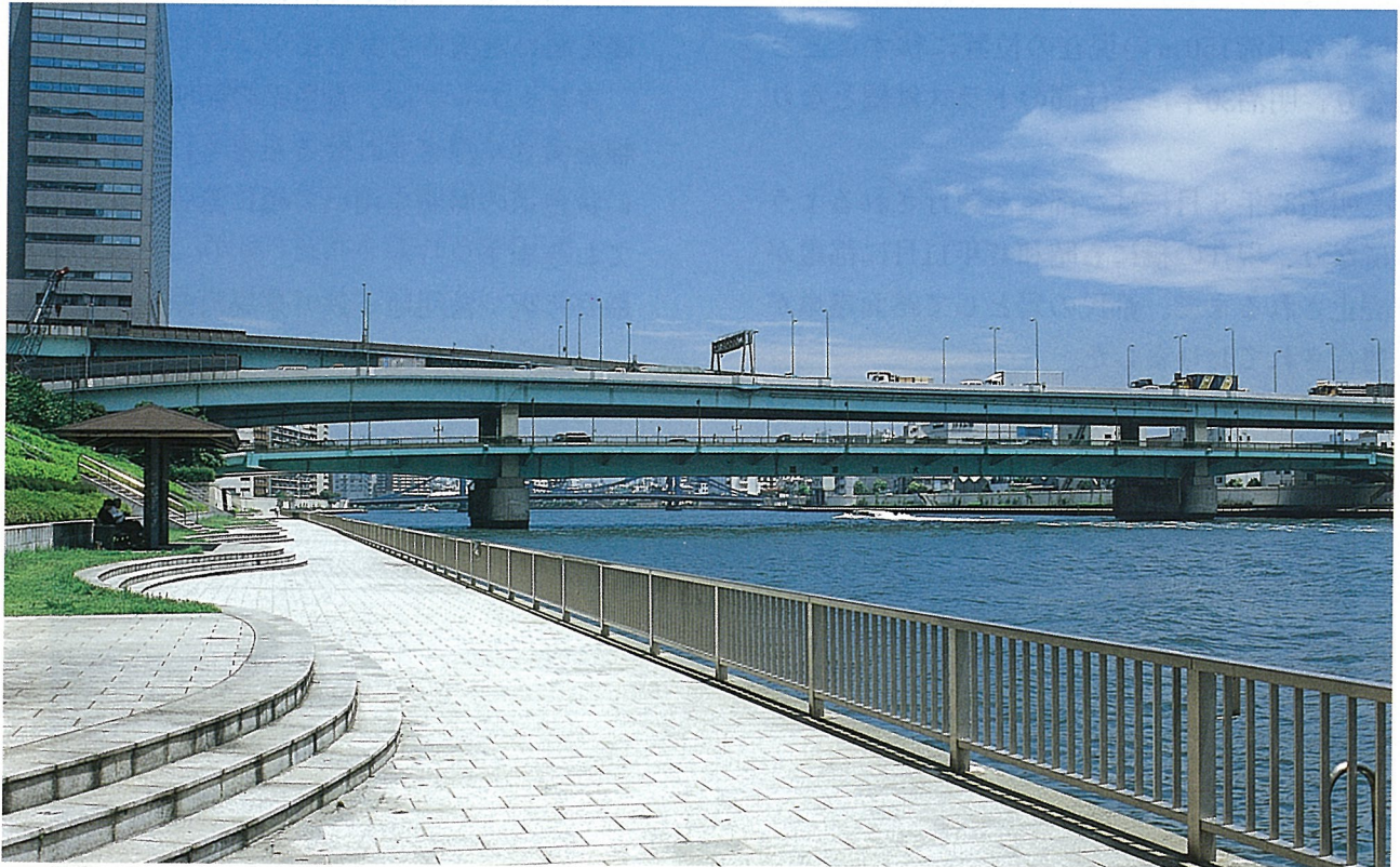
写真－8 隅田川大橋
