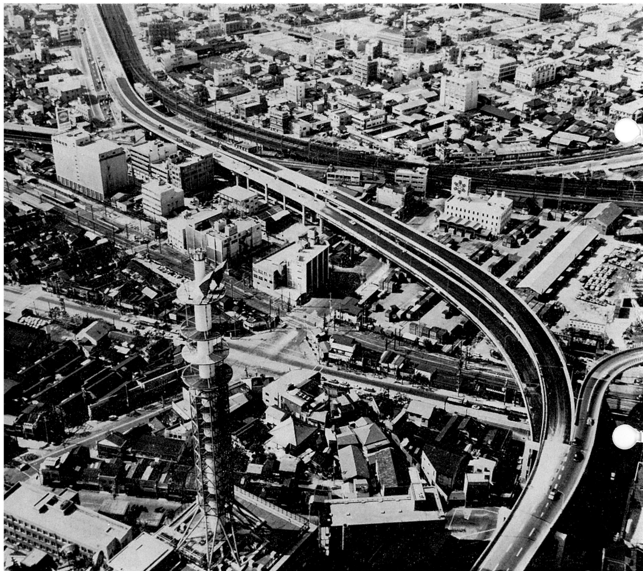
昭和42年度 福島第一高架橋（阪神高速）
