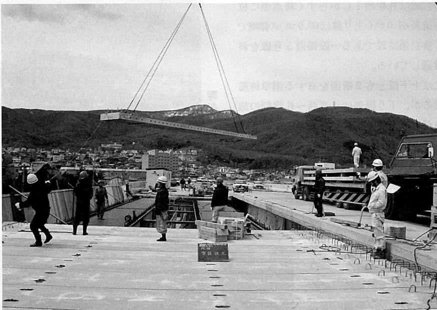
宮の沢橋プレキャスト床版架設状況
