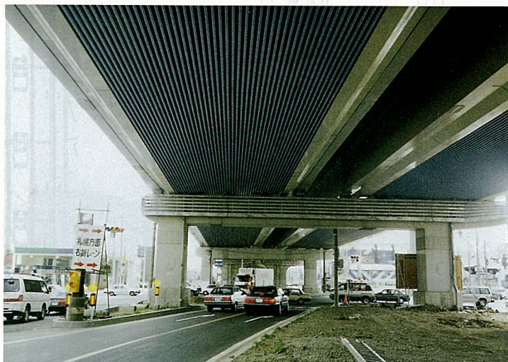
創成川橋（アルミルーバー）
