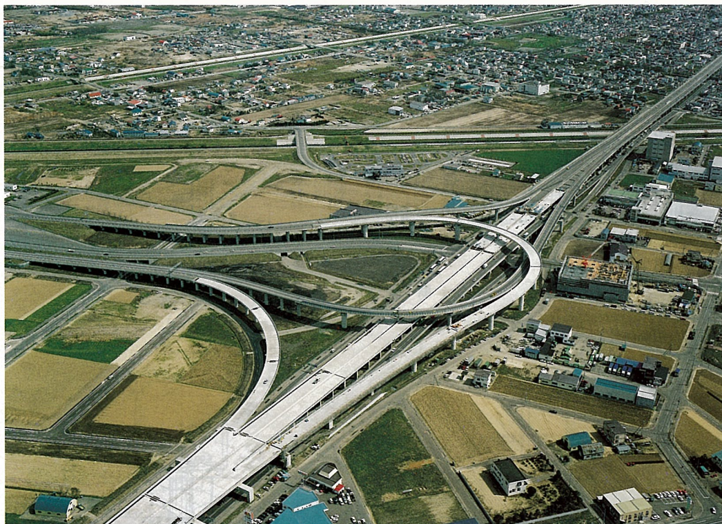
札幌ジャンクション橋
