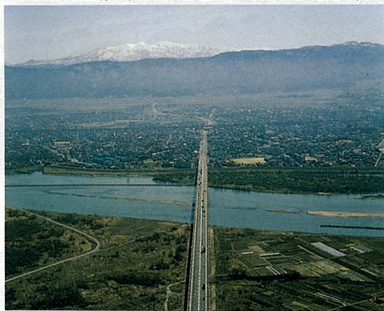
長岡大橋全景（正面に雪を頂く守門岳が見える）
