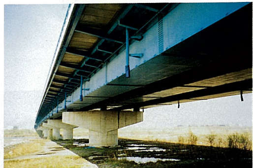
右岸上流側から望む雄峰大橋
