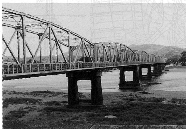
高知県第二の川「仁淀川」に架かる仁淀川橋
