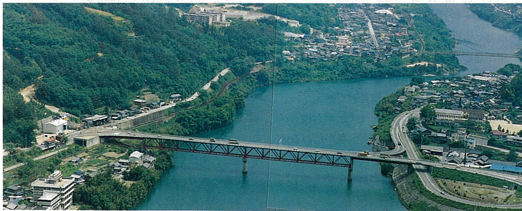
一般国道32号と一般国道192号の分岐点に架かる池田大橋
