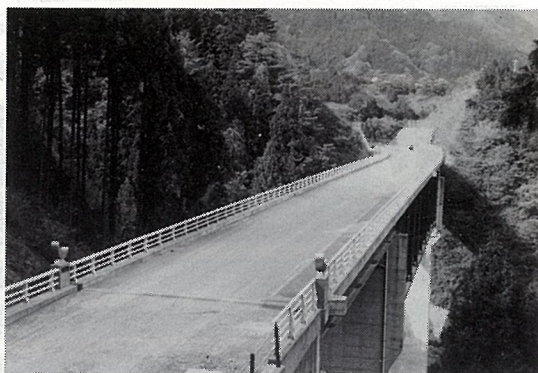
一般国道197号に架かる「桂月橋」
