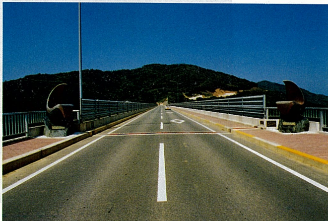
風・波・魚をモチーフした親柱と冬の季節 風から通行車両を守る防風柵(H=2m)
