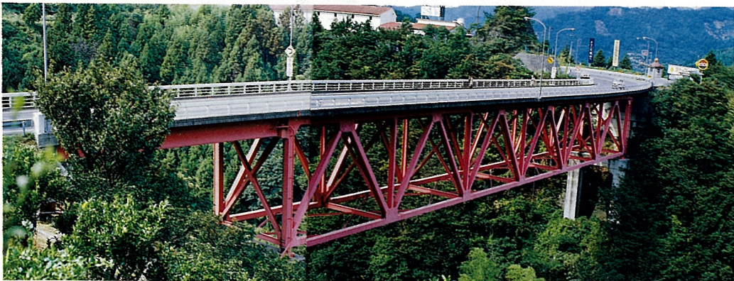
一般国道56号に架かる「犬寄大橋」
