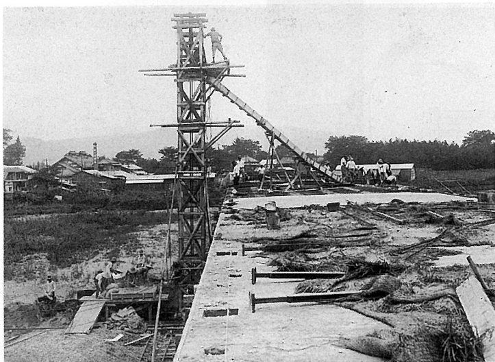
昭和初期の床版コンクリート打設状況
