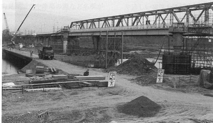
ニューマ チックケ ーソン基 礎の 施工状況
