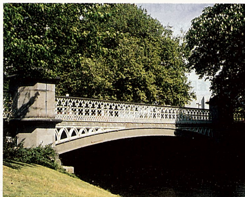
クライストチャーチ・ビクトリア橋
