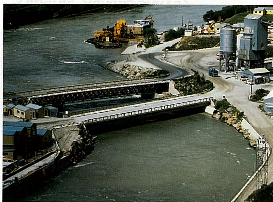
クライド・ダム放水路橋（手前）と工事用仮橋
