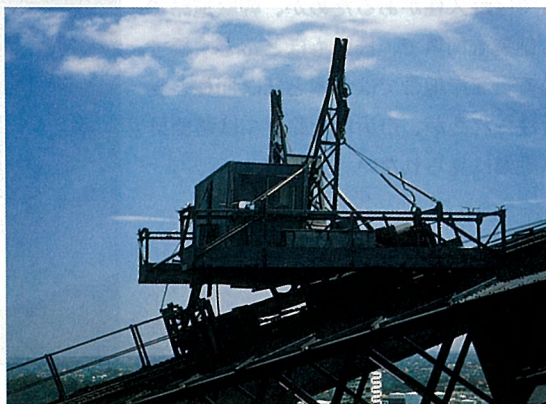
上弦材上の点検車 架設時の クリーパークレーンを再利用
