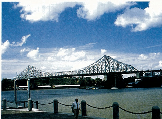
ブリスベーン川に架かるストーリー橋
