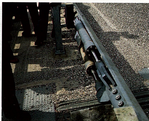
クロムウエル橋、ガードレールに免振装置
