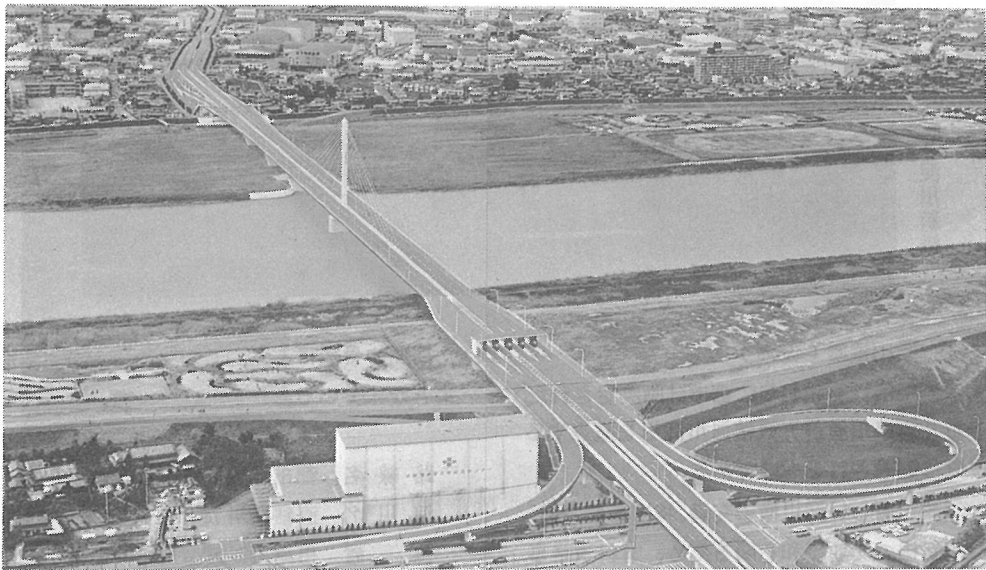
◀ 淀川橋梁（仮称）
