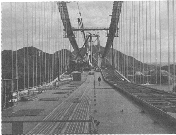
因島大橋（本四公団）の架設現場風景
