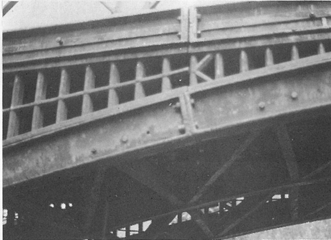
写真-6 铸铁製のブロック部材の接合（神子畑橋）
