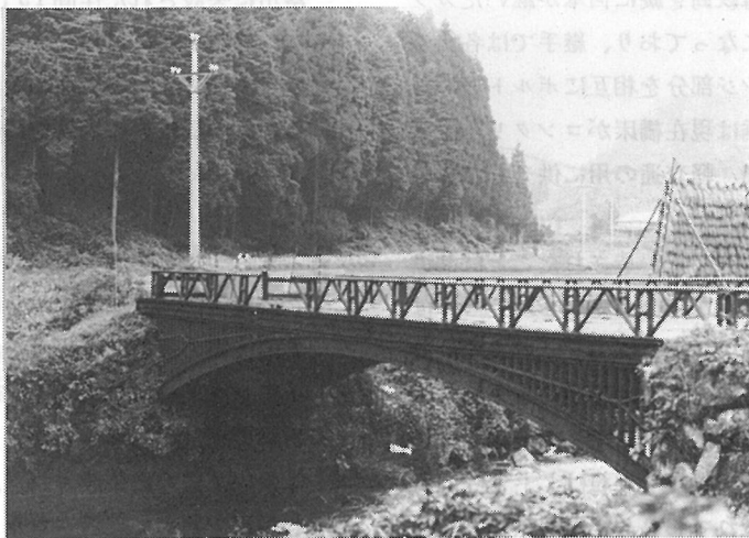
写真-5 現存する神子畑橋
