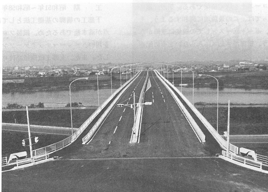
写真－３ 完成した河渡橋（左岸側より）
