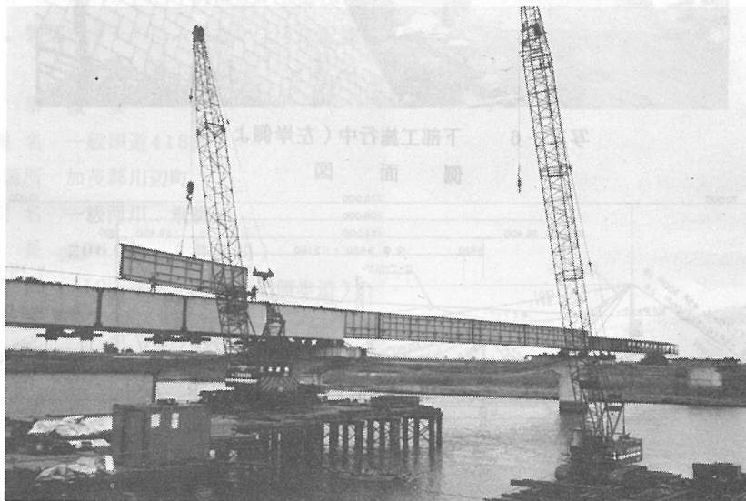
写真－１０ 架設中の油島大橋（手延工法）
