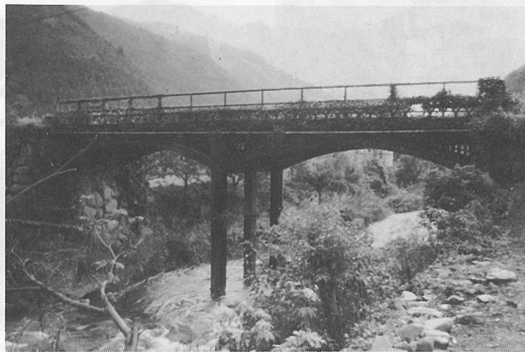
写真-2 羽淵鉄橋
