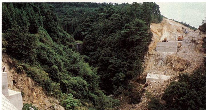
架設前の現場状況
