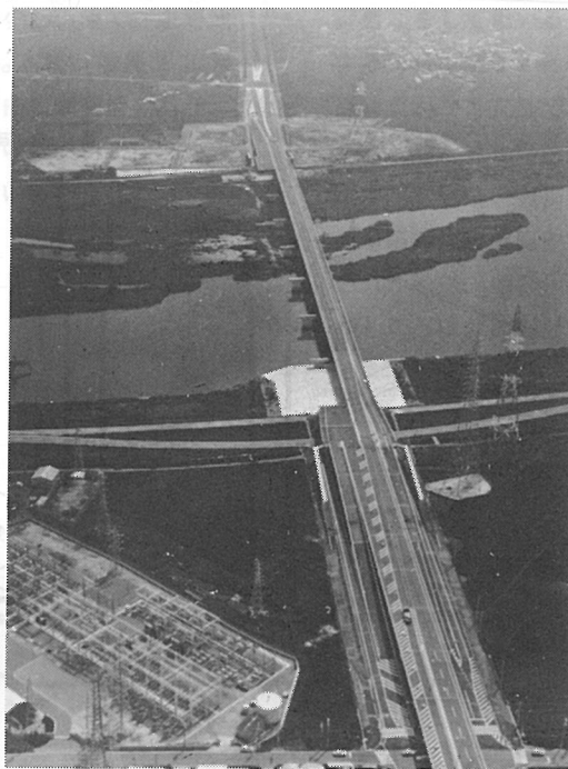
写真-8 播州大橋
