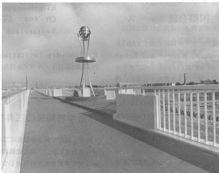
写真-10 上武庫橋
