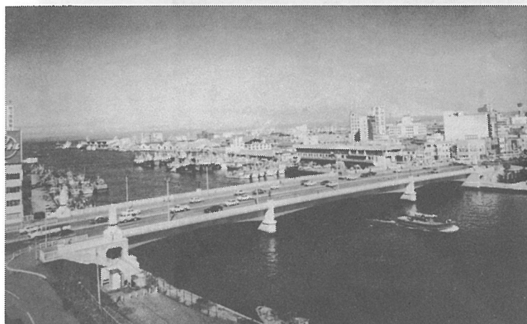
昭和51年完 写真-5 幣 舞 橋
