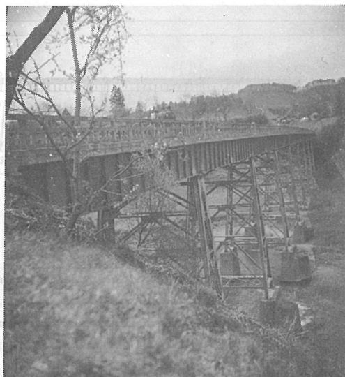
写真－5 青岩橋 昭和10年竣工
