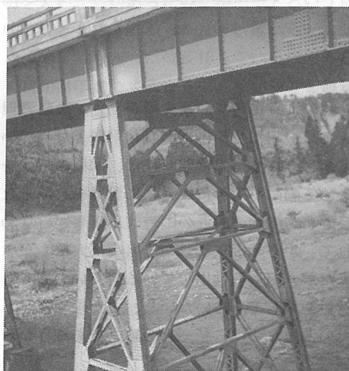
写真－6 青岩橋 昭和10年竣工
