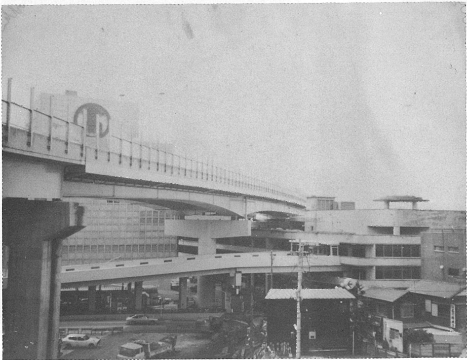
玉川高架橋（東京都）
