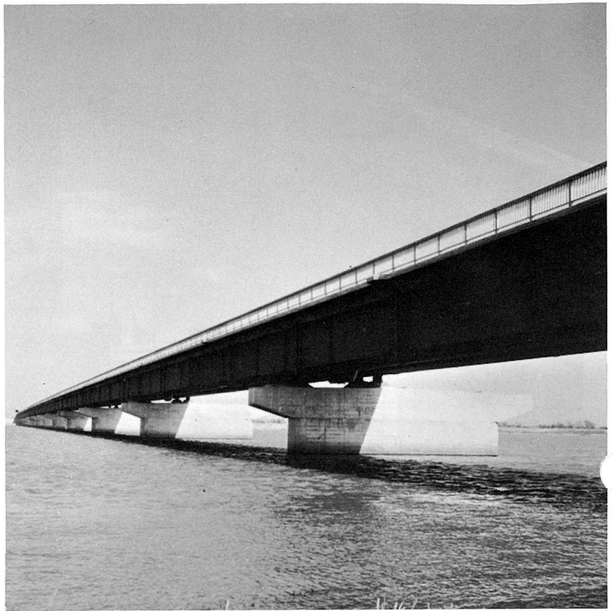
新泰平橋（新潟県）
