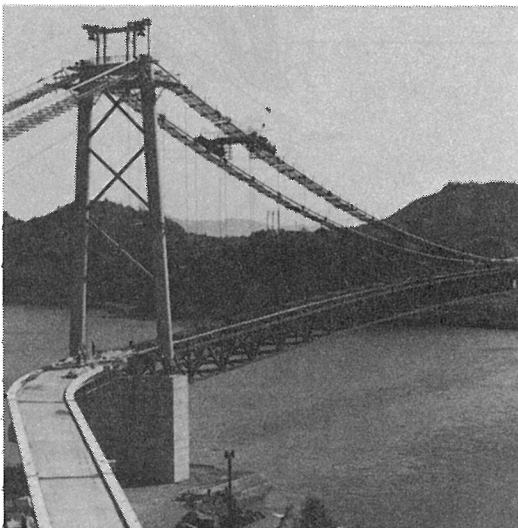
補剛トラス架設完了
