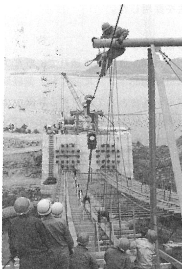
写真-2 P.W.S.の架設
