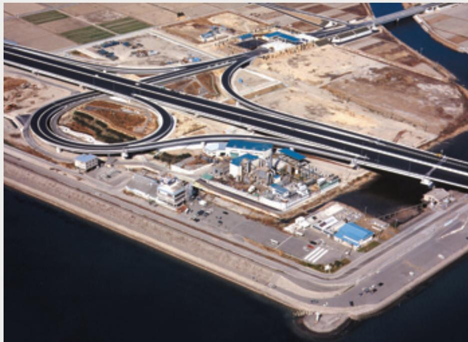
■本工事は、21世紀初頭の開通を目指す第二東名高速道路のインターチェンジ工事です。コスト低減を主眼として、プレキャストPC床版を用いた少数主桁橋梁が採用されており、工場で製作した床版を、移動台車上からのクレーン架設にて施工しました。
