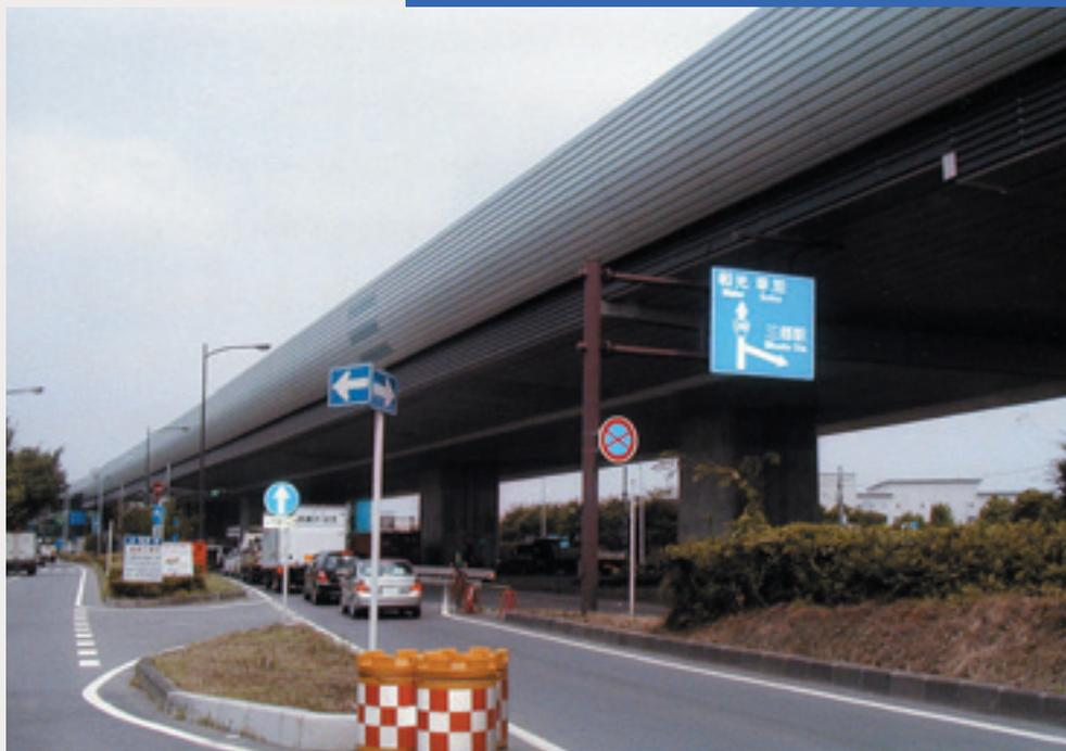
■本橋は、三郷JCT（埼玉県）の近傍に位置し、首都圏における交通渋滞の緩和や都市間の円滑な交通ネットワークを図った東京外環自動車道の一環を成しています。鋼横梁とコンクリート橋脚の複合構造、現場打ちPC床版の採用等の特長があります。一般国道298号上の高架橋であり、騒音軽減のため遮音壁や桁下吸音板を設置しています。
