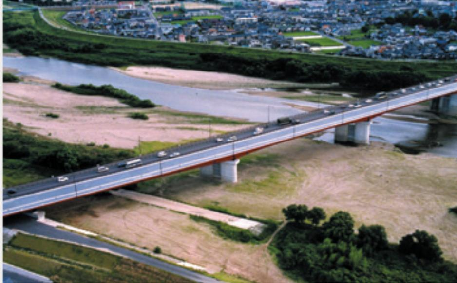
■本橋は、主要地方道名古屋岡崎線の1級河川矢作川に架かる、8径間連続鋼床版鋼箱桁橋です。橋長657mを有する連続鋼床版鋼箱桁橋としては、国内最大級の橋梁であり、舗装割れを配慮し鋼床版の現場継手部は溶接構造としました。また、地震を考慮し、支承は免震支承を採用しています。岡崎大橋の完成により、2車線から4車線となり、慢性的な交通渋滞が緩和されるとともに西三河地域の幹線道路ネットワークの形成が進み、地域の発展に貢献することが期待されています。
