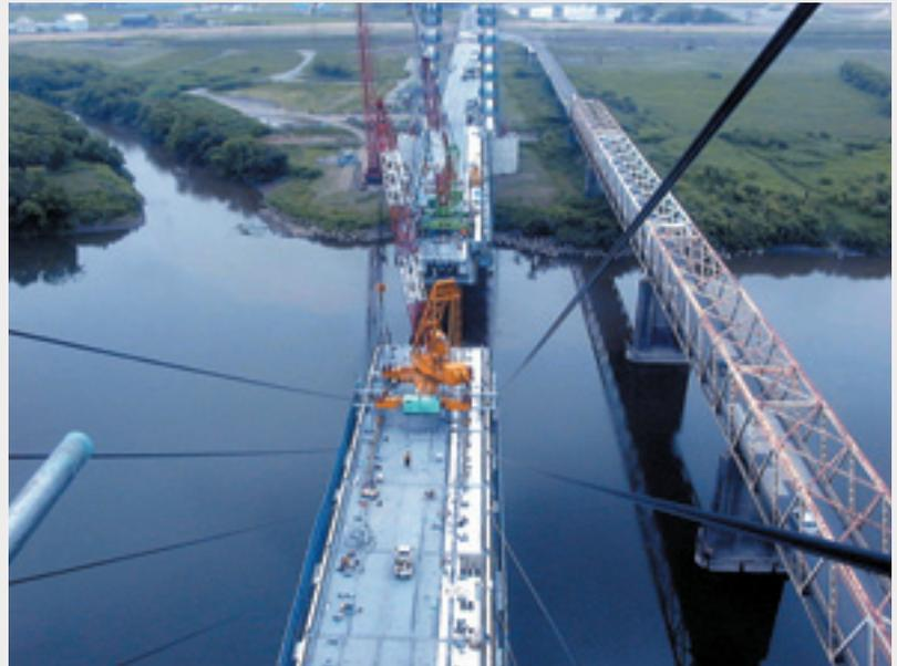
■本橋は、石狩平野の中核都市岩見沢市と札幌道央圏北部域を結ぶ道道路線の岩見沢石狩線にあり、北海道の母なる川といわれている石狩川を渡河しています。主塔と側径間の架設は200t及び300t吊クローラークレーン、中央径間はトラベラクレーンによる張出し架設を行いました。本橋の形式美が広大な石狩平野とよく調和しており、周辺の自然環境と融合した姿を映し出しています。
