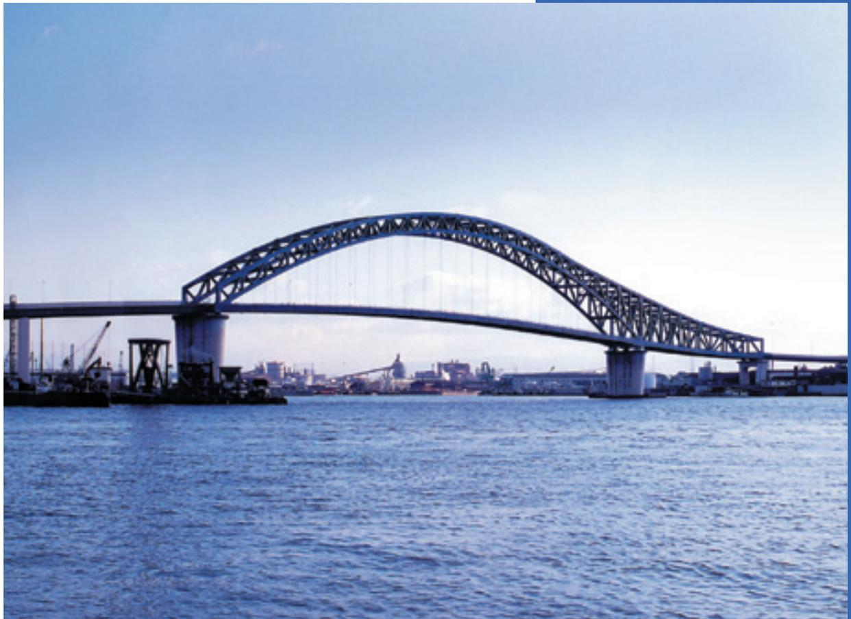
■大阪市大正区内の大正内港に建設された全長約1kmの橋梁群の中における主橋梁部です。一般府道大阪八尾線（大正通り）の混雑緩和を図るとともに同区域内の一体性を高め、地域の活性化を促すものです。架設は、トラス部とアーチ部の2ブロックに分け、フローティングクレーンによる大ブロック架設工法で行いました。
