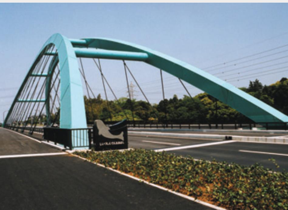
■本橋は、市原市椎津地先の中台堰を越える橋梁で、国道16号を補完する都市幹線道路として活用されています。中台堰の自然環境を保全するために、桁下にベントを用いないケーブルクレーン斜吊り工法にて架設し、外観色には青緑色を採用して自然環境との調和を図っています。
