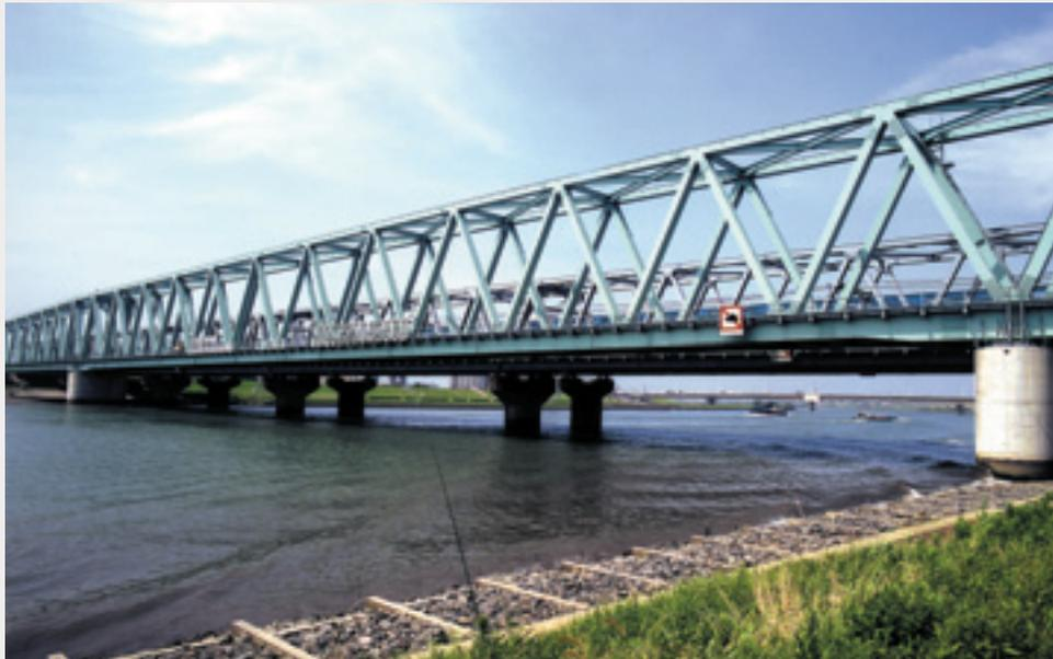
■本橋は、つくばエクスプレスが荒川を足立区内において渡河する鉄道橋です。河川に及ぼす影響等を検討し、鉄道単独橋として日本最大の中央支間長が192.85mを有する鋼トラス橋となっています。また耐候性鋼を使用するにあたり、景観を考慮し着色型錆安定化処理を施しています。営団千代田線、JR常磐線、つくばエクスプレスの3つの荒川橋梁が並んでいる姿は圧巻で、一見の価値があると思います。
