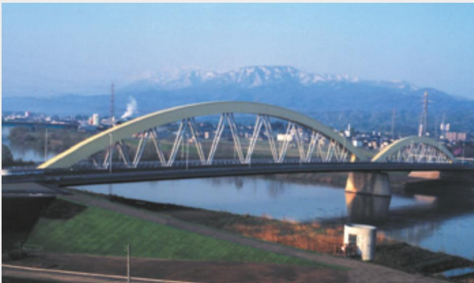
■本橋は、1級河川関川に架かる、北陸地方最大級の単弦ローゼ橋です。アーチライズを抑えた大小2連のアーチが遠景の妙高連山と見事に調和する本橋は、上越市の幹線道路謙信公大通りのシンボルとなる橋梁です。構造的には、アーチの断面が台形で、しかもこの断面がアーチ軸に沿って変化するという非常に珍しい特徴を持っており、架設についても、自走多軸台車を用いてアーチリブの一括架設を行うという珍しい工法で施工されました。また、地域の特性上、冬季の落雪対策としてアーチ部に融雪装置を設置しており、通行者の安全にも配慮した市民に親しまれる橋として期待されています。
