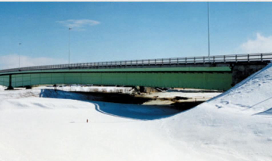
■本橋は、千歳市を起点とし小樽市に至る地域高規格道路である道央圏連絡道路当別バイパスの当別川に架かる、最大スパン134m、桁高が3.4m～6.8mに変化する変断面の形状を有する長大橋です。平成15年3月に開通し地域ネットワークの一翼を担っています。
