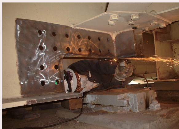
写真―5 狭い空間での作業
