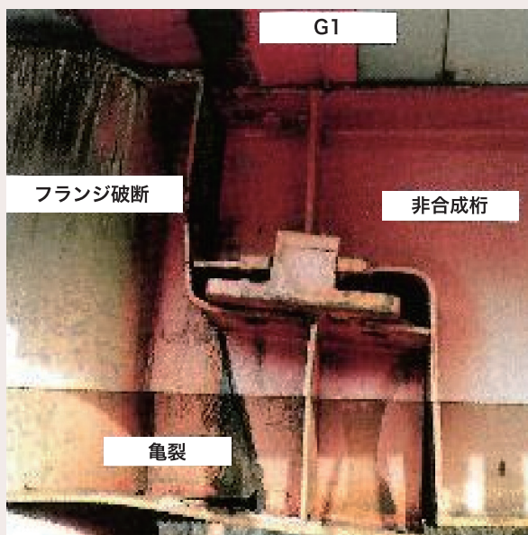
写真-2 山神橋亀裂損傷
