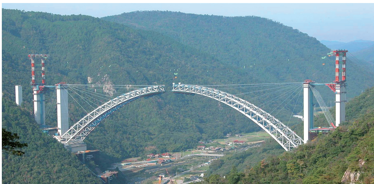
写真-1 アーチリブ閉合直前状況
