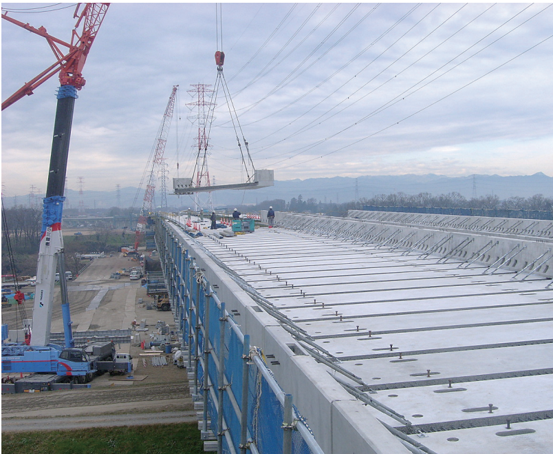
床版と防護柵の一体化架設
