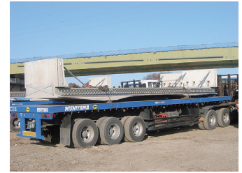
床版と防護柵の一体化輸送
