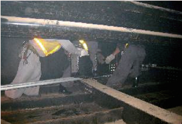
写真-6 人力による運搬
