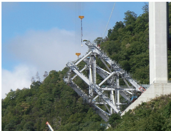
写真-4 アーチ基部架設状況
