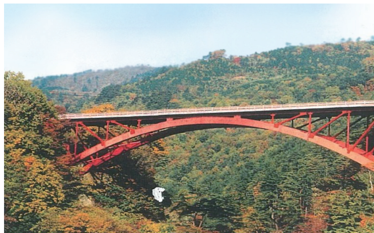
写真-4 補強後の山神橋
