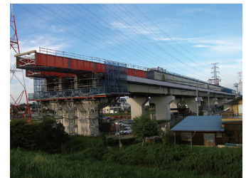
既設橋梁上での地組立
