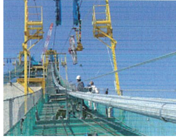
ケーブル架設 (エアスピニング工法)
