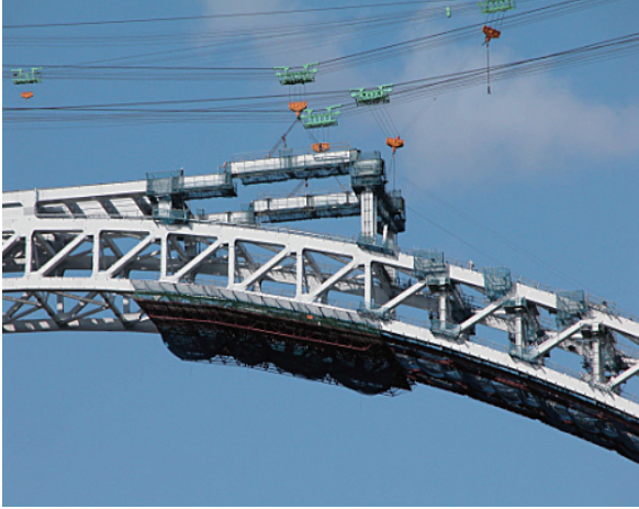
写真-8 補剛桁架設状況
