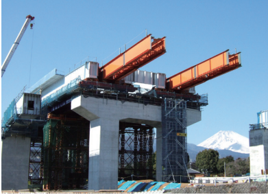
本線桁送出し架設
