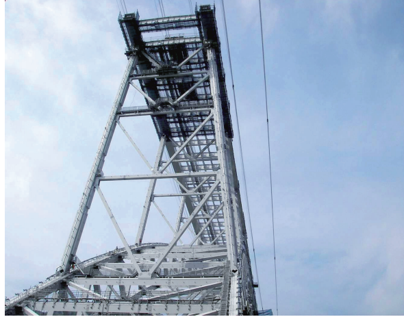
写真-9 支柱架設状況
