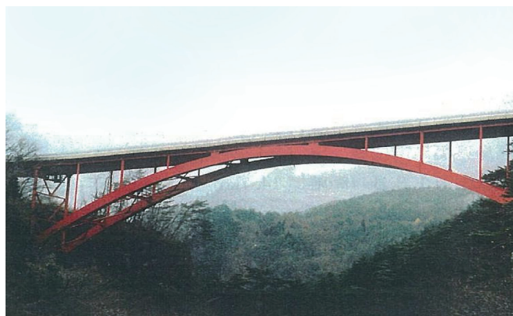
写真-3 補強前の山神橋
