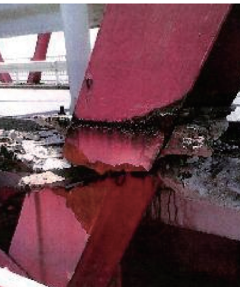
写真-1 木曾川大橋斜材破断
