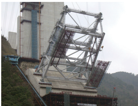
写真-6 移動防護工設置状況
