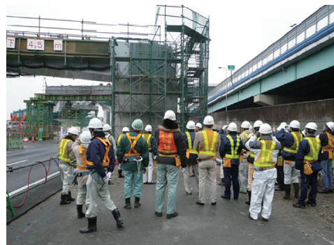
複合橋脚接合部の見学
