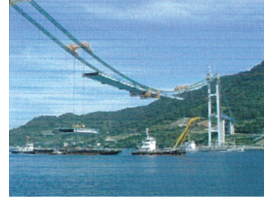
補剛桁架設 (直下吊工法)
