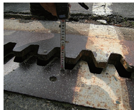
国道342号 岩手県 市野々原橋
