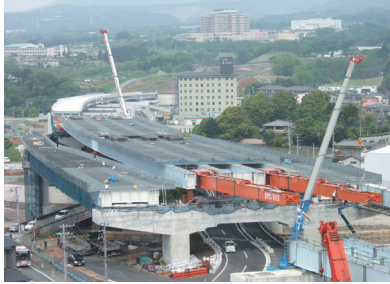
本線桁送出し架設完了
