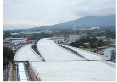
床版施工完了
