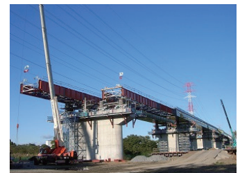
送り出し架設
