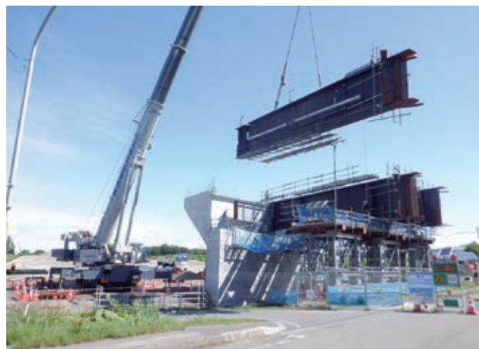
架設中 (A2側G1桁)
