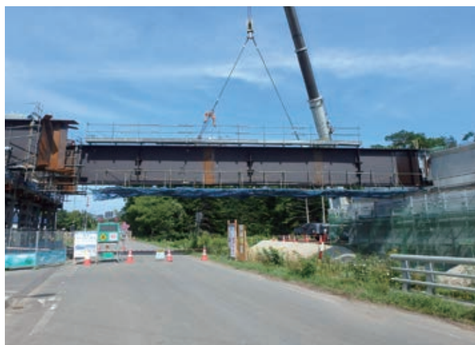
架設中 (A1側G2桁)
