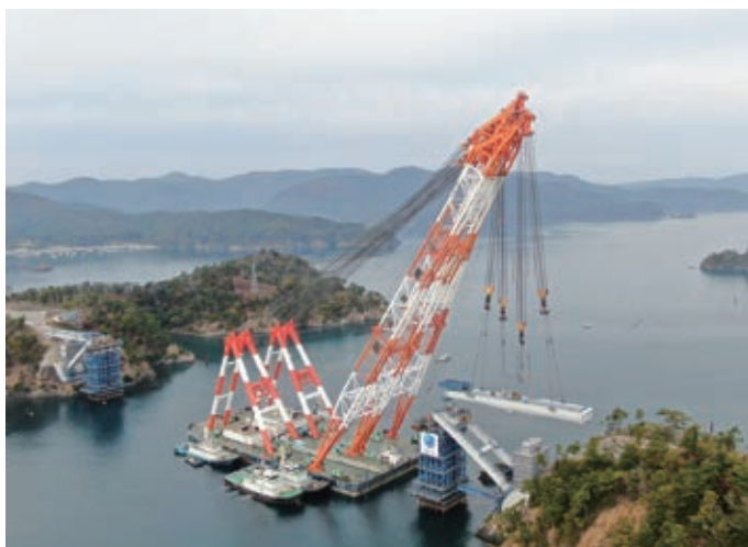
側径間ブロック FC架設
