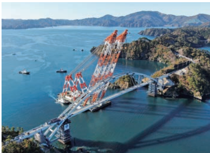
中央径間ブロック FC架設
