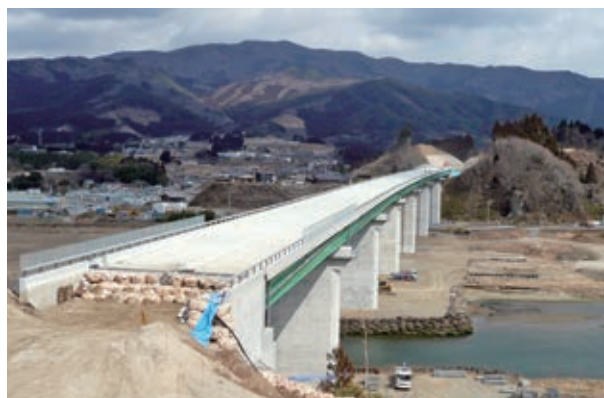
床版と壁高欄まで完成した気仙川大橋
