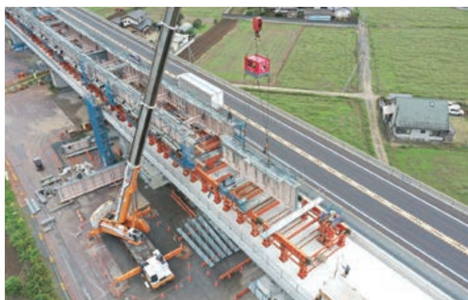
送出し桁架設
