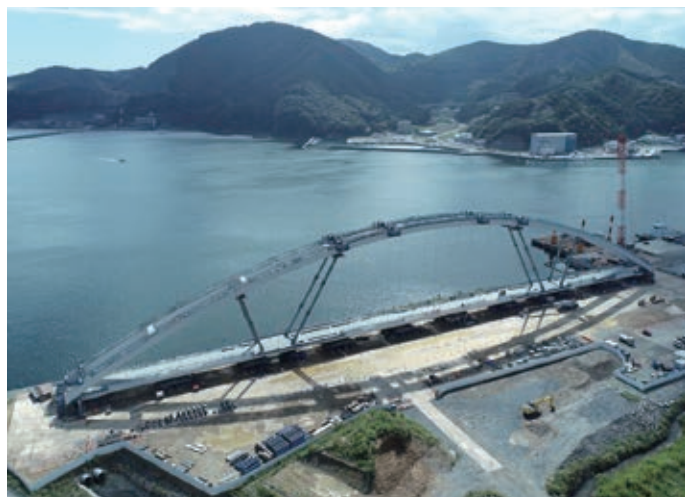
中央径間ブロック地組立完了
