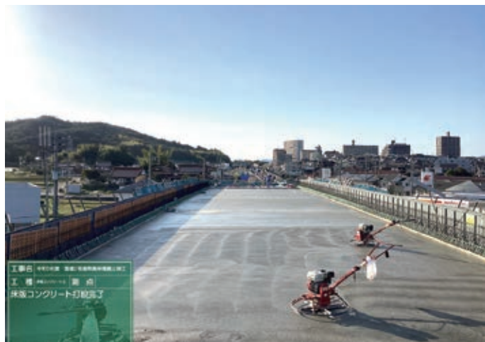
床版コンクリート打設完了
