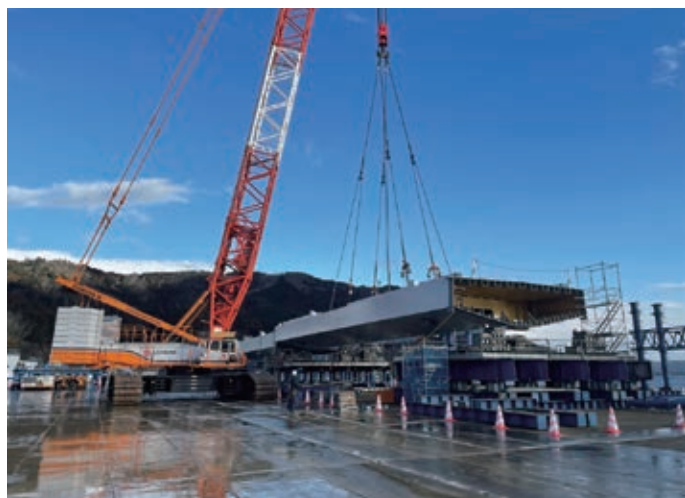
中央径間地組立補剛桁架設
