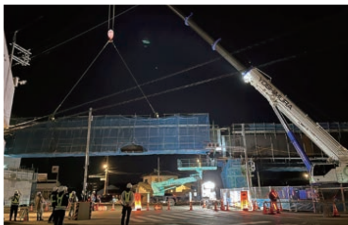
大型クレーンによる桁架設
