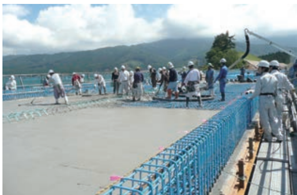
コンクリート打込み状況
