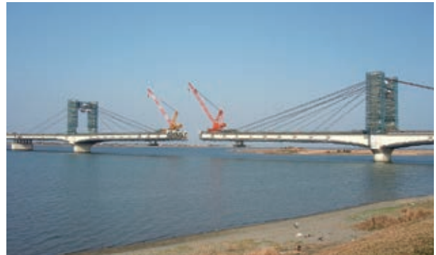
トラベラクレーンによる架設
