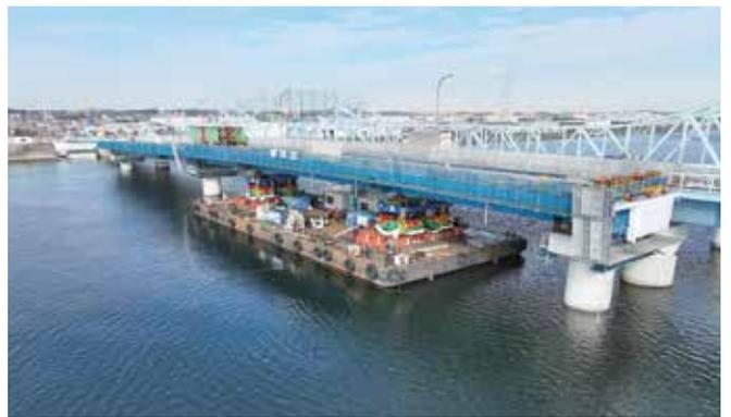
大ブロック桁台船架設状況
