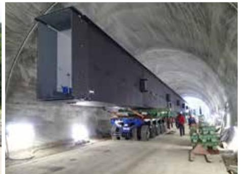
地組立ヤードから7号トンネルに向けて、多軸式特殊台車による運搬
