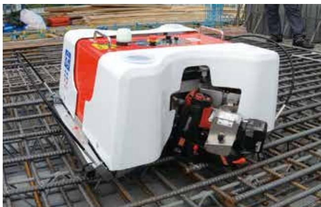
これまで人力であった床版鉄筋の結束作業を自動化し、省力化により生産性が約14%向上します。作業員の現場作業が削減されるため、転倒事故や熱中症等の労働災害リスクを軽減できます。
