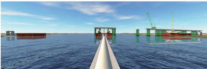
STEP-2 P4-P5間スプリング・補剛桁クレーン架設
