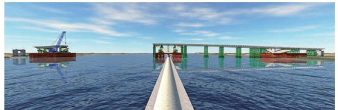
STEP-3 P5-P6間補剛桁送し架設
