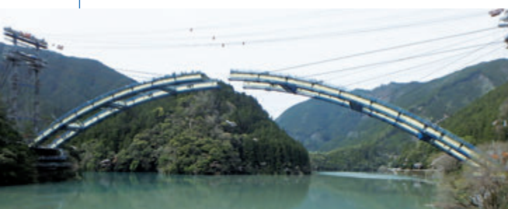
アーチリブ架設1
