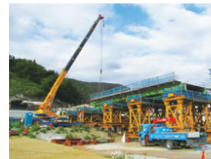
軌条桁架設
