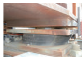
ジャッキアップ後の支承と桁の縁切り状況
