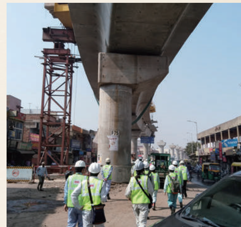
アーメダバード地下鉄現場視察
