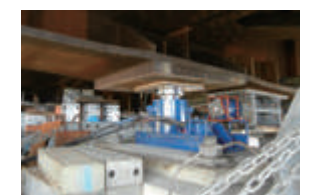
中間支点桁移動設備
