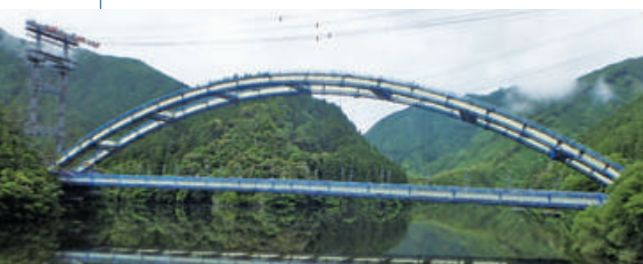
アーチリブ架設2
