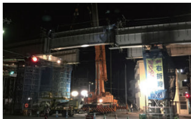
P625-P626架設状況
