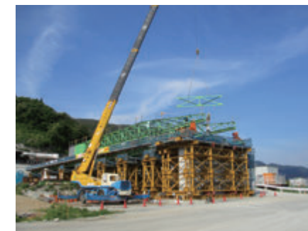
手延べ機架設
