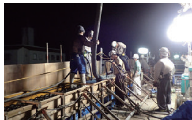
P625-P626コンクリート打設
