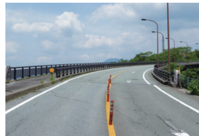
着工前 橋面 (A1側からA2側を展望)
