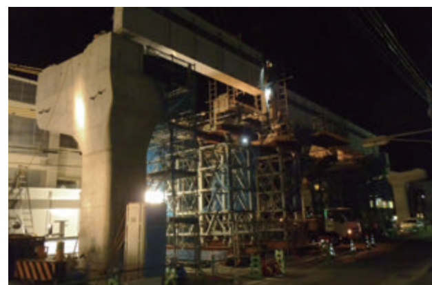
P644-P645架設状況
