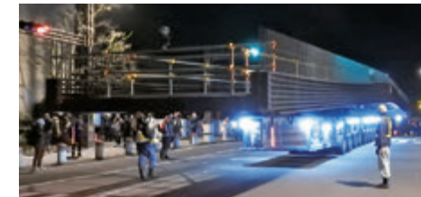
陸上輸送（多軸台車で運搬）
