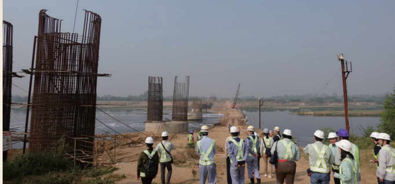
DFCC鉄道橋現場視察
