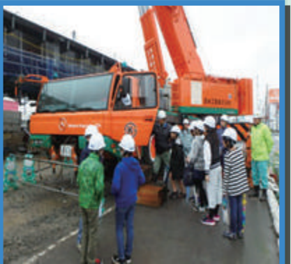
架設用重機の乗車体験
