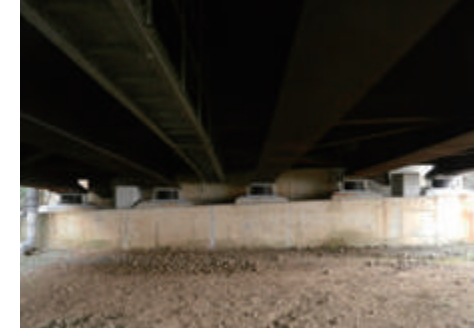
完成後 A1橋台
