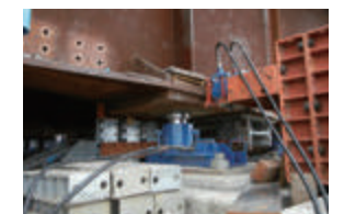
中間支点桁移動設備 (側面)
