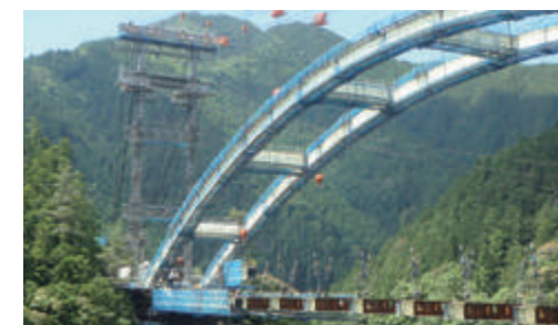
補剛桁架設
